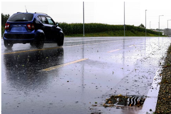
Entwässerung Kantonsstrasse. © AWA
