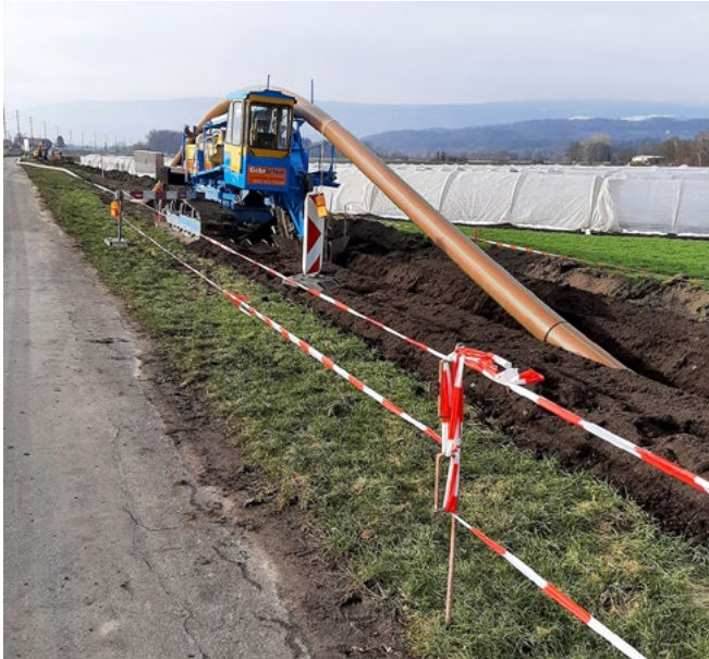
Bau Anschlussleitung ARA Ins an ARA Marin. © ARA Ins
