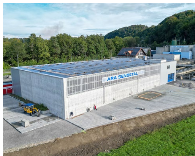
Neubau Behandlungsstufe zur Elimination von Mikroverunreinigungen auf der ARA Sensetal. © ARA Sensetal
