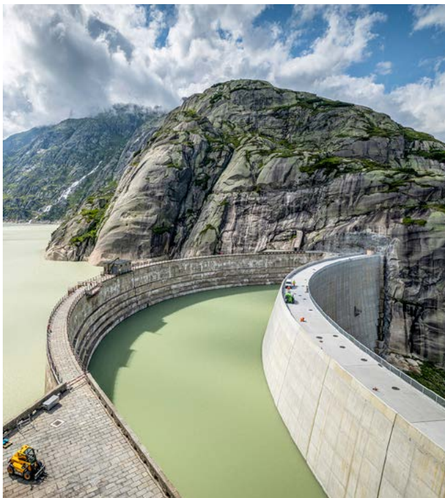
Die Staumauer Spitallamm am Grimselsee ist wichtig für die Stromproduktion im Kanton Bern. Da sie über 90 Jahre alt und sanierungsbedürftig ist, baute die KWO seit 2019 vor der alten Mauer eine neue, die 2025 fertig gestellt wurde. Damit wird sichergestellt, dass das Wasser aus dem Grimselsee langfristig ohne Einschränkung für die Stromproduktion genutzt werden kann. © KWO / David Birri
