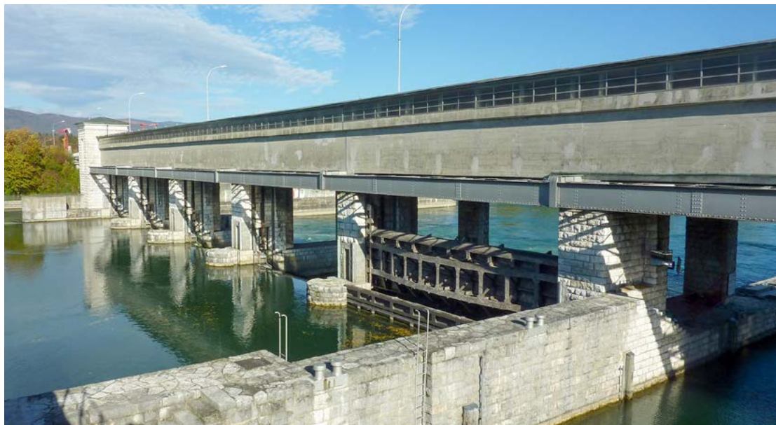
Das Regulierwehr bei Port am Ausfluss des Bielersees, Schlüsselement der Gewässerregulierung im Kanton Bern. © BVD-AWA
