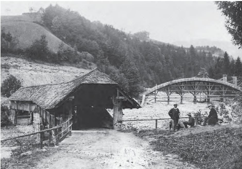
Abb. 14 (oben): Die Aufnahme vom Senseübergang bei Guggersbach an der Strasse Guggisberg-Plaffeien dokumentiert das Nebeneinander von Alt und Neu im Brückenbau. Die alte Holzbrücke wurde 1906 durch eine Hochbrücke ersetzt, die sich auf dem Bild im Bau befindet. (Quelle: 850 Jahre Guggisberg, 1998)
