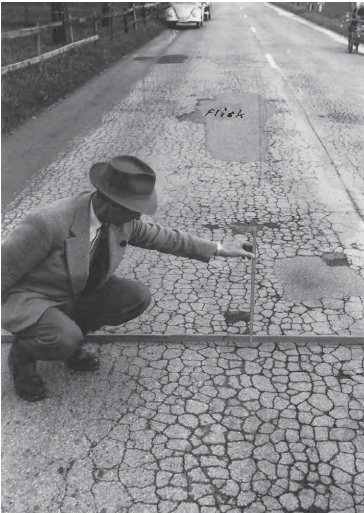
Abb. 46: Schadensaufnahme an der Hauptstrasse Bern–Thun im Jahr 1947. Der Befund zeigt das charakteristische Bild der Schäden nach dem Krieg, bei denen sich der zu schwache Unterbau und die Defizite der frühen Asphaltbeläge verstärkten. In der Dokumentation der Schäden ist vermerkt «Zusammenbruch von Tragschicht und Belag». Der stärkere Verkehr und die höheren Fahrzeuggewichte erforderten die Ersetzung der zu geringen Tragschichten und der überalterten Leichtbeläge. (Foto: Tiefbauamt, Oberingenieurkreis II, Bern)
