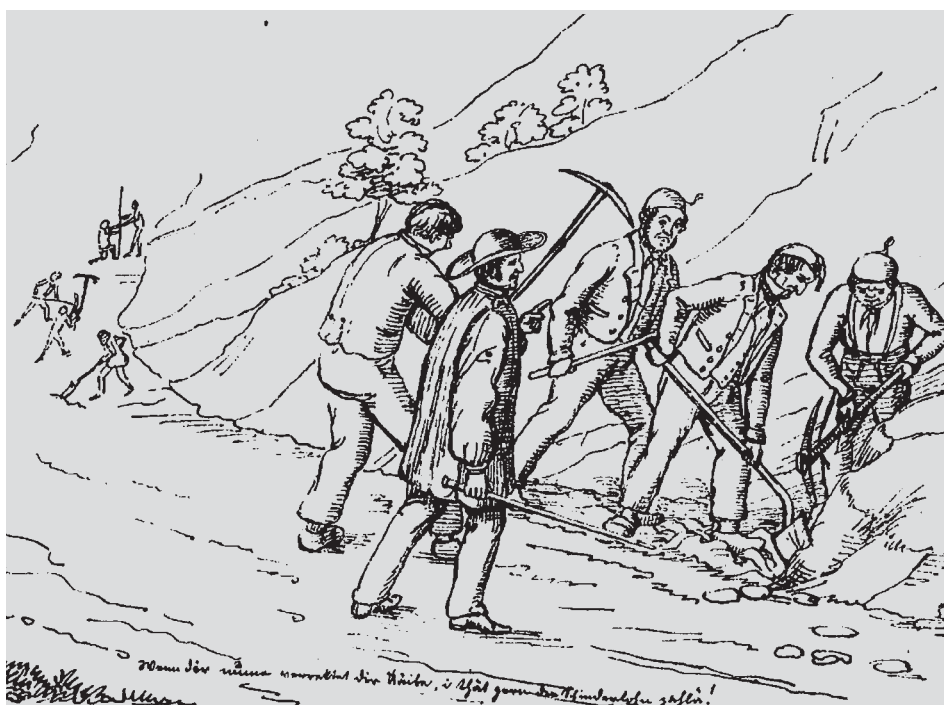
Abb. 19: Die Karikatur aus dem Guckkasten von 1846, einer Zeitschrift der Berner Radikalen, mit dem Titel «Wie man im Laufenthal die Strassenarbeiter beaufsichtigt» bringt etwas überspitzt die sozialen Unterschiede auf der Baustelle zum Ausdruck. Der Aufseher mit Jacke, Hut und Stock, die ihn als hablichen Landmann kennzeichnen, geisselt die Zipfmützen tragenden Arbeiter mit den bösen Worten «Wenn dir neme verrecktet, dir Käibe, i thät gern der Schinderlohn [= Lohn für Kadaverbeseitigung] zahlä!». (Quelle: Flückiger, 2009)
