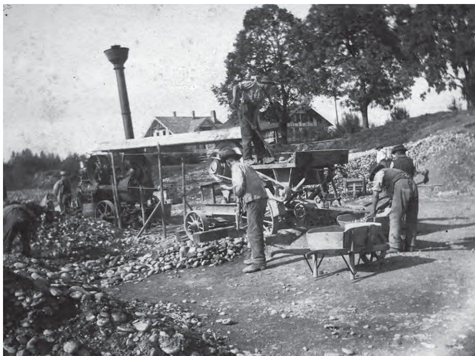
Abb. 29: Steinbrecher und Teerkocher irgendwo auf bernischen Strassen. Der Verwaltungsbericht von 1905 meldete die Anschaffung einer Steinbrechermaschine des Mechanikers Ammann: «Dieselbe ist imstande, bis kopfgrosse Steine, welche sonst vielfach unverwendbar in den Kiesgruben oder Flussbetten herumliegen, zu geeignetem Strassenkies, besonders zum Einwalzen, zu zerkleinern, und zwar bis 20 m 3 per Tag.» (Foto Tiefbauamt, Oberingenieurkreis I, Thun; VB 1905, 273)
