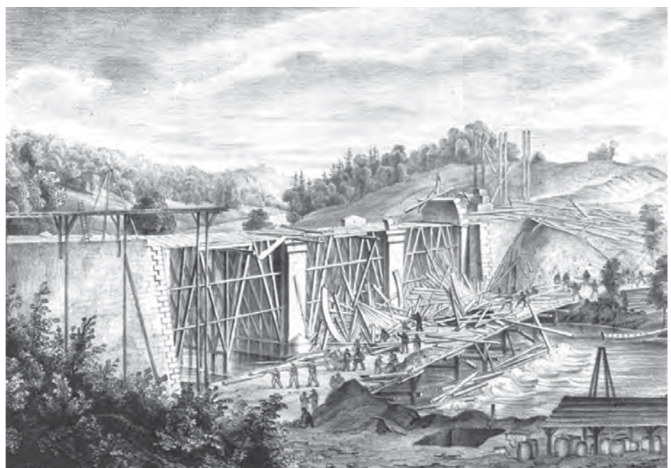
Abb. 8: Die Tiefenaubrücke nach dem während eines Sturms am 11. Juni 1847 erfolgten Einsturz des Baugerüsts. Lithographie von J.F. Wagner. (Quelle: Historisches Museum, Bern)
