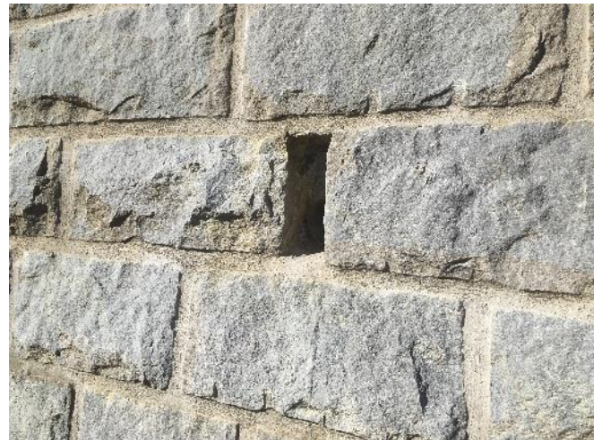
Abb. 63: Gutes Beispiel einer Entwässerung quer zur Mauer mit Entwässerungsschlitz
