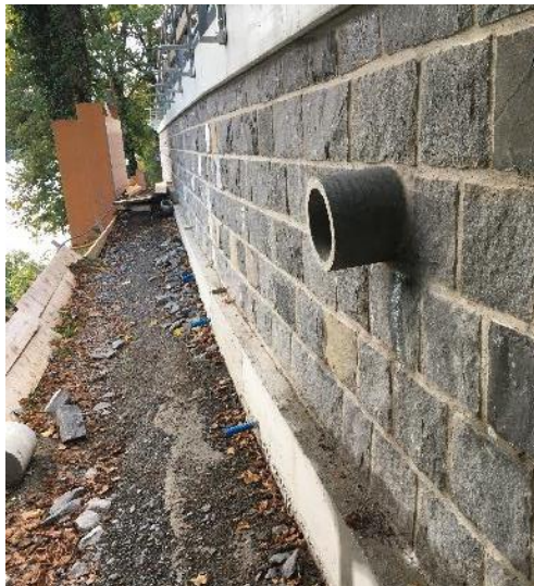
Abb. 62: Gutes Beispiel einer Entwässerung quer zur Mauer mit Zementrohr
