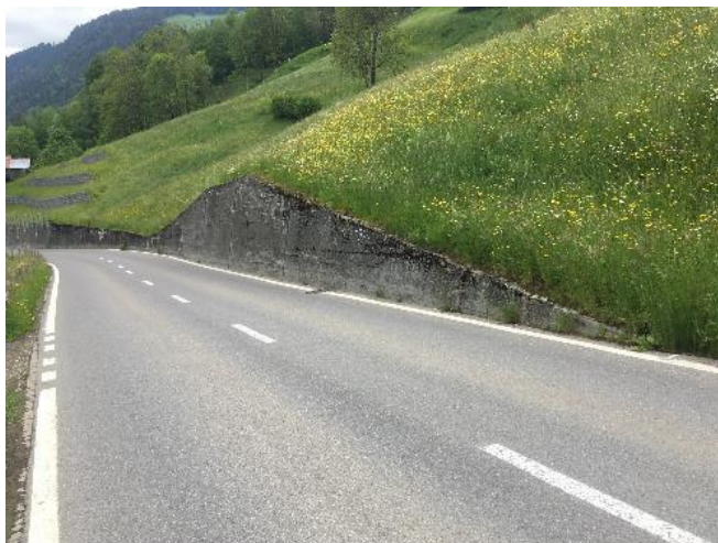
Abb. 11: Gutes Beispiel für eine Stützmauer, die ins Terrain bzw. auf «Null» ausläuft
