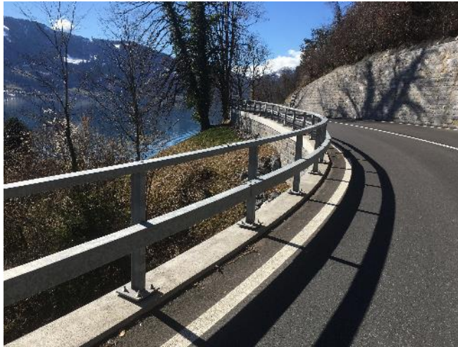
Abb. 77: Beispiel eines Fahrzeugrückhaltesystems mit Kastenprofil und Handlauf wie es nicht mehr eingesetzt werden soll
