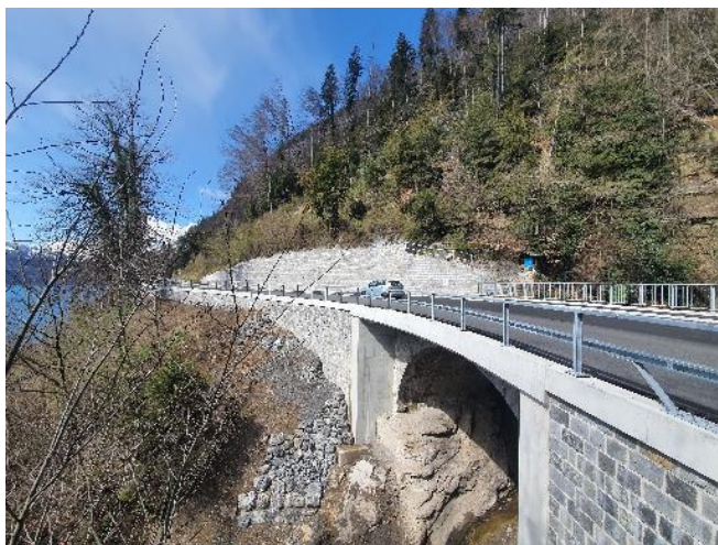
Abb. 19: Beispiel einer als eigenständiges Bauwerk sorgfältig gestalteten Brücke; unterschiedliche Bordürenhöhen wirken eher unruhig: Besser wäre in dem Fall, wenn die Widerlagerwände bis in die Ebene der Bordüren hervorstehen würden
