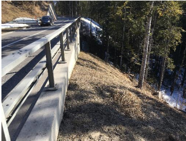
Abb. 9: Gutes Beispiel für den Anschluss einer Steilböschung an eine Stützmauer mit begehbare Berme
