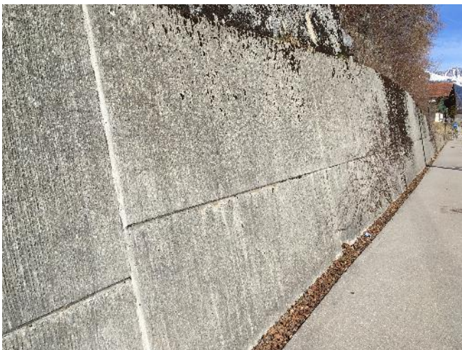
Abb. 38 und 39: Gestalterisch nicht mehr zeitgemässe und unwirtschaftliche Lösung einer Mauer Oberfläche mit Strukturschalung (Schilf) und unschönen Schattenfugen
