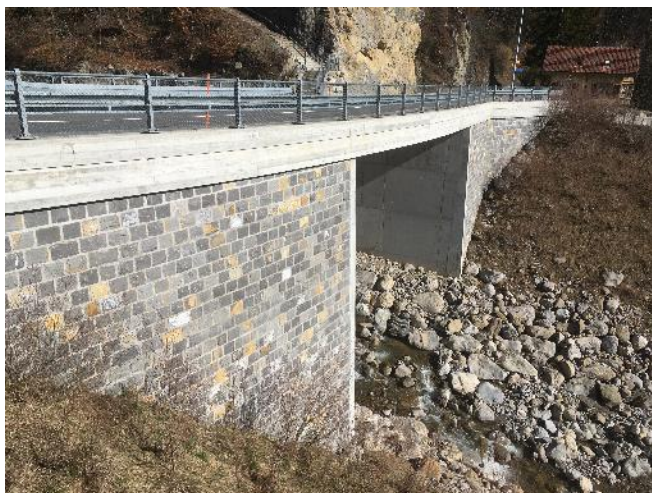
Abb. 21: Gutes Beispiel mit Flügelmauern als Teil der Brücke; dank durchgehender Bordürenhöhe wirkt das Gesamtbauwerk harmonisch
