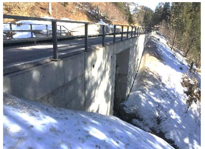
Abb. 22: Gutes Beispiel dank minimalistischer Gestaltung mit Flügelmauern als Teil der Brücke und ohne hervorstehende Bordüre
