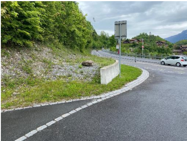
Abb. 15: Gutes Beispiel einer Mauer als optisches Leitelement (aus Gründen der Wirtschaftlichkeit zurückhaltend einsetzen)
