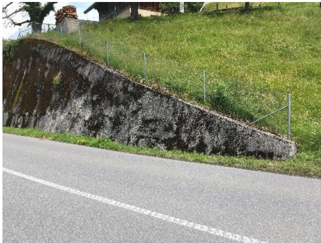
Abb. 69: Gutes Beispiel einer Spritzbetonmauer mit geschalter Krone, die dem Terrain folgt
