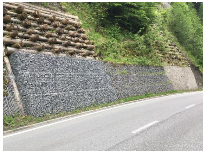
Abb. 73: Steinkorbmauer in permanenter Rutschzone; mit zwei unterschiedlichen Systemen unmittelbar übereinander ist die Lösung gestalterisch inakzeptabel
