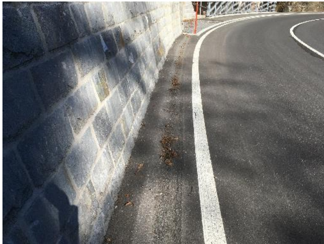
Abb. 44: Gutes Beispiel mit bis an Mauer gezogenem Belag, mit Quergefälle von Mauer weg und gefräster Entwässerungsrinne zur Vermeidung von querlaufendem Wasser
