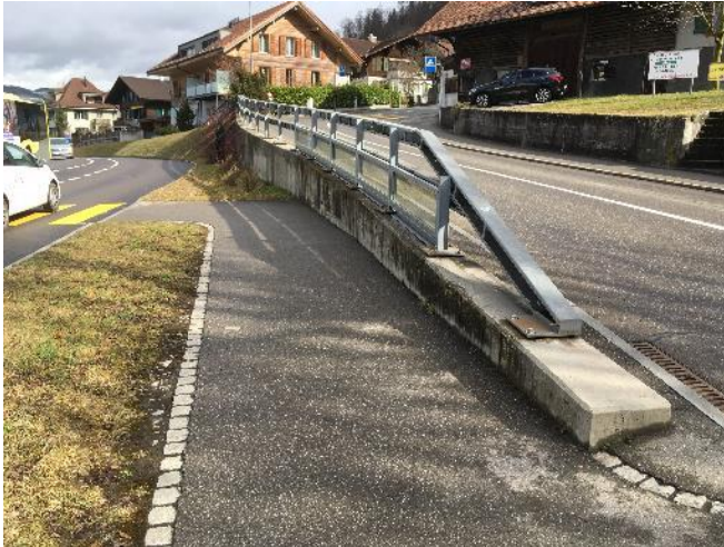
Abb. 1 und 2: Gutes Beispiel zweier höhenversetzter Strassen: Die Stützmauer folgt der oberen Strasse
