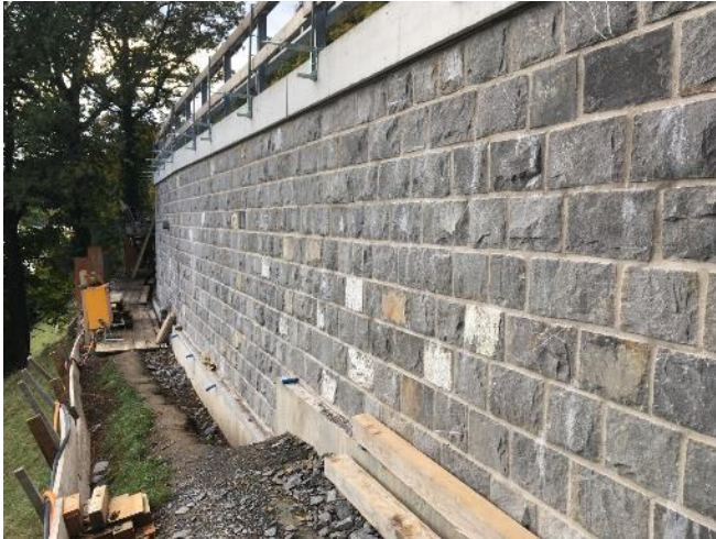
Abb. 48: Gutes Beispiel einer Bordüre über Natursteinverkleidung, Ausführung polygonal und gegenüber Natursteinoberfläche hervorstehend
