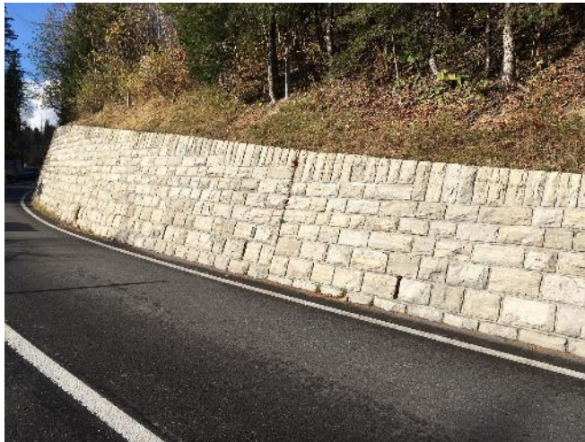
Abb. 39: Gutes Beispiel eines Schichtenmauerwerks mit Roll-schar
