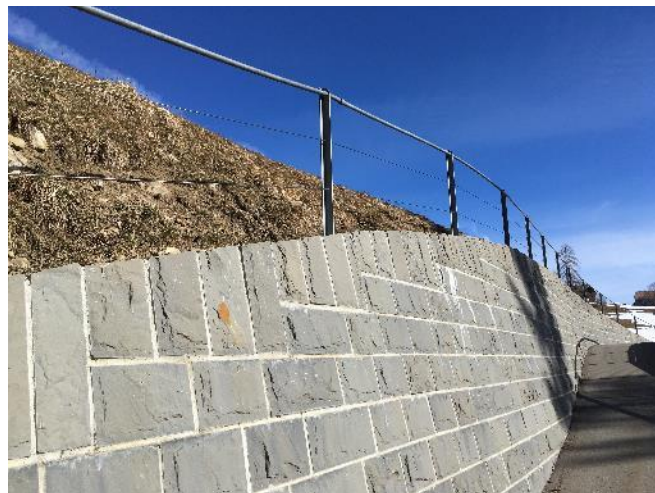
Abb. 75: Gutes Beispiel einer Absturzsicherung auf der Mauerkrone für ein Weidegebiet (gemäss Arbeitshilfe wäre kein Geländer erforderlich)
