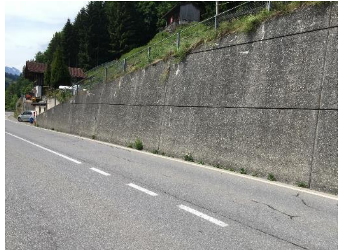
Abb. 37: Gestalterisch ungünstige Lösung einer Mauer Oberfläche mit Waschbeton und zusätzlichen Schattenfugen
