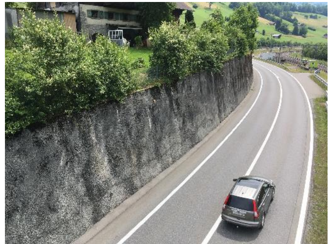
Abb. 70: Gutes Beispiel einer Spritzbetonmauer mit geschalter Krone
