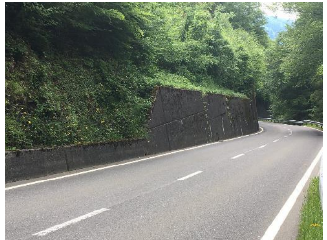
Abb. 4: Mauer zu streng geometrisch mit wenig Bezug zur Topografie (gestalterisch ungünstige Lösung)
