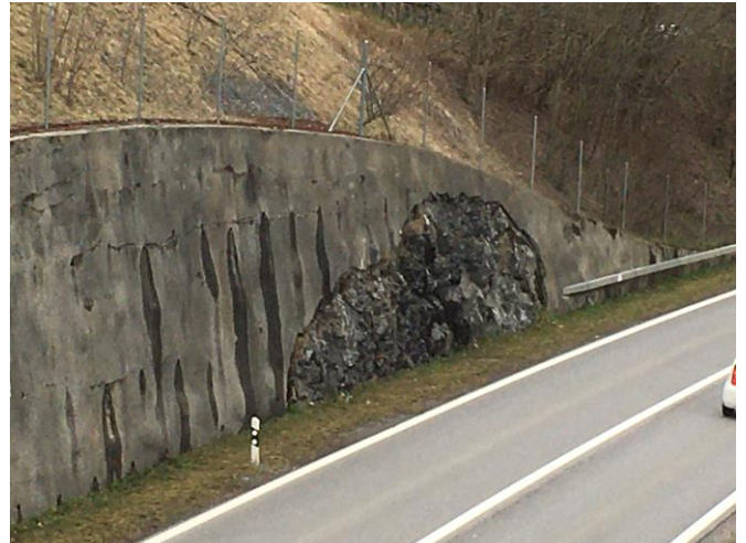
Abb. 67: Beispiel einer Spritzbetonmauer mit integriertem Felsvorsprung zeigt die Flexibilität des Spritzbetons zur Anpassung an bestehende Geländeformen.
