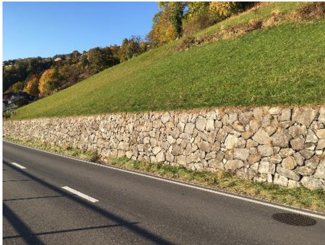
Abb. 55: Sehr schöne Mauer: ideales Verhältnis von Steingrösse zu Mauerhöhe, sehr ebene Oberfläche, sehr schmale Fugen sowie gut ausgeführte Krone
