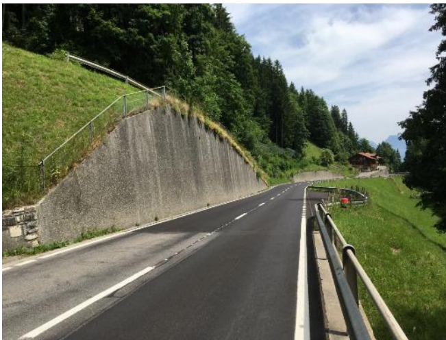
Abb. 3: Gutes Beispiel einer Mauerkrone, die dem Terrain folgt
