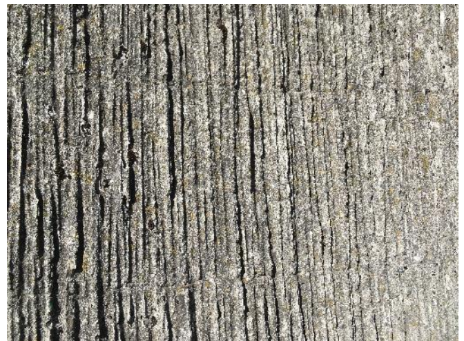
Abb. 38 und 39: Gestalterisch nicht mehr zeitgemässe und unwirtschaftliche Lösung einer Mauer Oberfläche mit Strukturschalung (Schilf) und unschönen Schattenfugen
