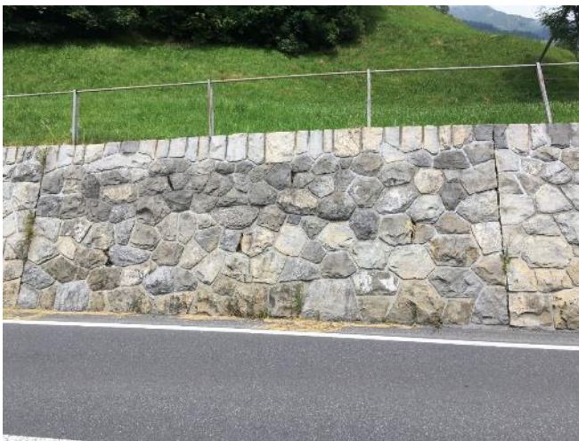
Abb. 60: Gutes Beispiel eines Zyklopenmauerwerks
