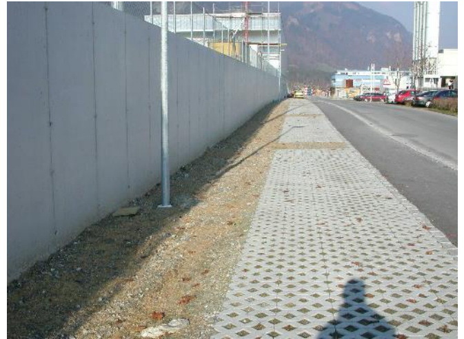
Abb. 6: Gutes Beispiel einer horizontalen Mauerkrone bei einer ungleich geneigten Strasse im Siedlungsgebiet (Mauerkrone nicht parallel zur Strasse)
