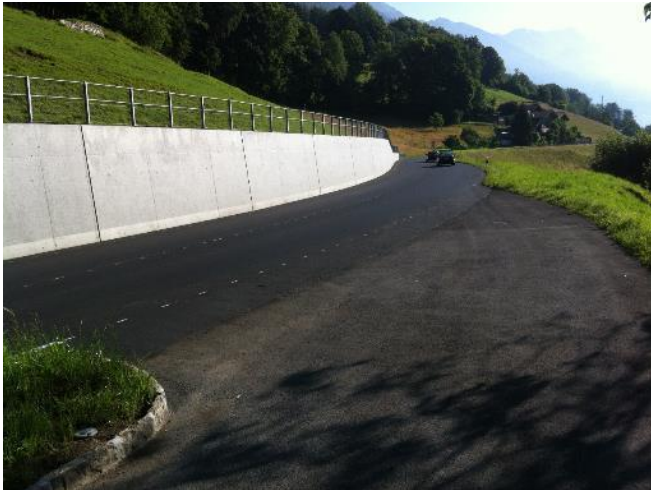
Abb. 36: Gutes Beispiel einer sandgestrahlten Mauer Oberfläche bei einer exponierten Stützmauer
