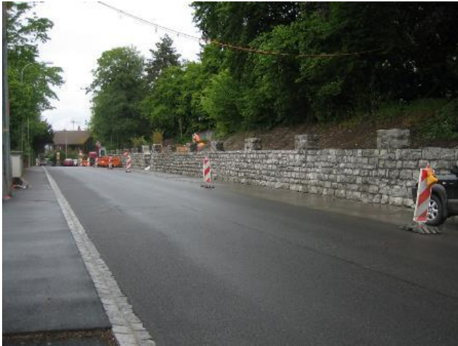
Abb. 5: Gutes Beispiel einer Mauerkrone parallel zur Strasse
