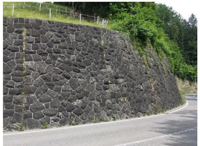
Abb. 61: Gutes Beispiel eines Zyklopenmauerwerks
