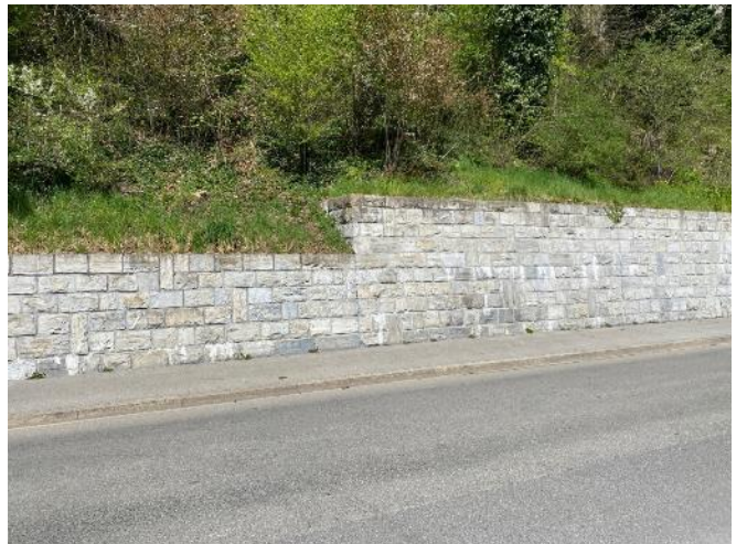
Abb. 16: Gutes Beispiel einer Stützmauer mit rechtwinkligem Abschluss eines Höhenversatzes
