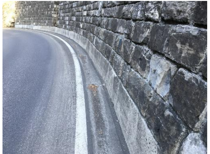
Abb. 45: Beispiel eines Betonsockels im Mauerfuss mit in den Belag gefräster Entwässerungsrinne
