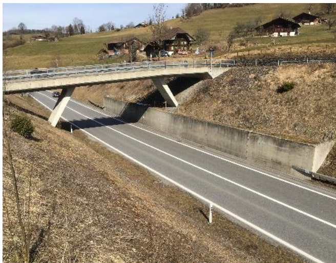
Abb. 25: Gutes Beispiel mit Stützmauer und Brücke/Überführung als jeweils eigenständige und unabhängige Bauwerke; zum überzeugenden Erscheinungsbild tragen die rechtwinkligen Mauerabschlüsse bei
