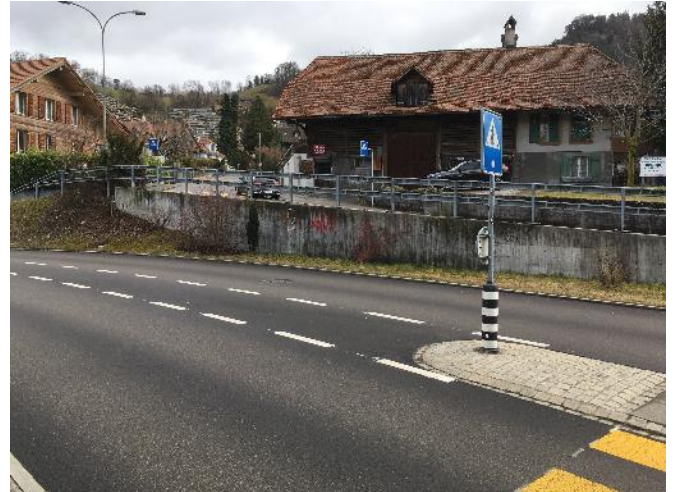
Abb. 1 und 2: Gutes Beispiel zweier höhenversetzter Strassen: Die Stützmauer folgt der oberen Strasse
