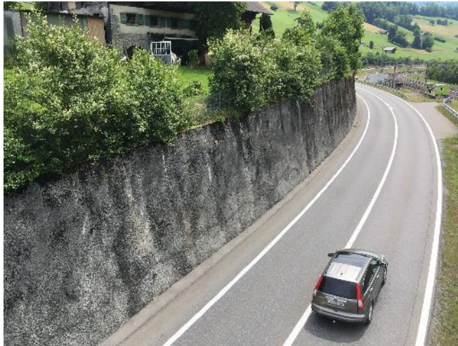
Abb. 66: Gutes Beispiel einer Stützmauer aus Spritzbeton
