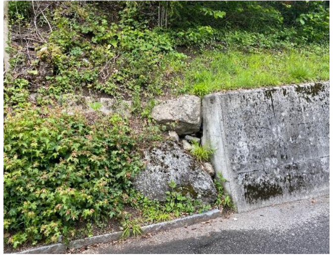
Abb. 14: Mauer ist zu kurz; der unsachgemässe Anschluss an das Gelände ist gestalterisch inakzeptabel
