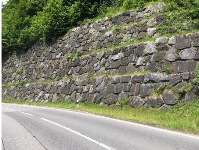
Abb. 51: Dank der Bermen gutes Verhältnis von Steingrösse zu Mauerhöhe, ebene Flächen zur Strasse, maximal zulässige Fugengrösse eingehalten und gut ausgeführte Kronen
