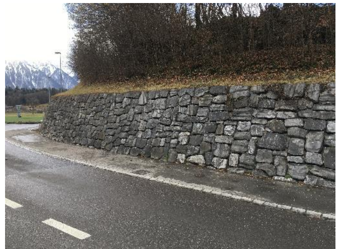
Abb. 42: Gutes Beispiel eines Gemischtmauerwerks ohne Roll-schar, jedoch mit sauber ausgeführter, stetiger Krone
