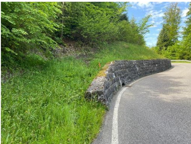
Abb. 17: Beispiel eines Mauerabschlusses mit erkennbarem Gestaltungswillen; die Stirne sollte aber etwas weniger hoch und die Mauer entsprechend länger sein
