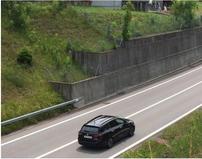
Abb. 13: Gutes Beispiel für einen Abschluss der Stützmauer rechtwinklig zur Strasse
