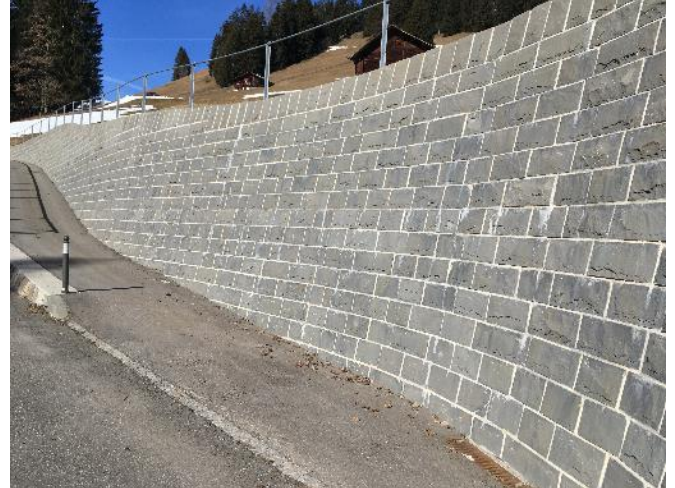
Abb. 59: Gutes Beispiel eines Schichtenmauerwerks, Lagefugen horizontal (Gefälle Strasse/Fussweg bis ca. 10 %)
