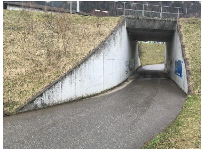
Abb. 24: Gutes Beispiel von Stützmauern resp. Flügelmauern als Verlängerung der Brückenwiderlager; Überbau und Mauern bilden eine Einheit
