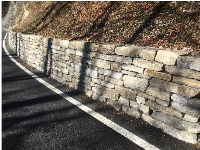
Abb. 57: Schönes Beispiel eines als Trockenmauer ausgebildeten Gemischtmauerwerks; gutes Verhältnis von Steingrösse zu Mauerhöhe, sehr schmale Fugen, sauber ausgeführte Krone
