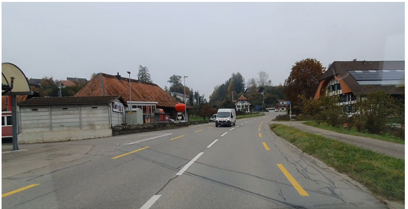
Foto Ist-Zustand, Blickrichtung Murten, Einmündung der Murtenstrasse (Zufahrt Bahnhof) in der linken Bildhälfte
