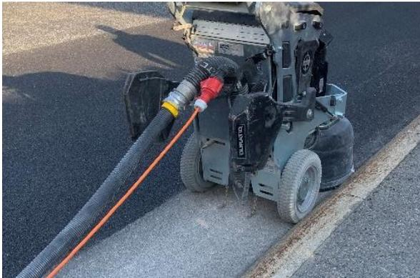
Abbildung 5: Abschleifen eines SDA 4 Belags mit einer Schleifmaschine.
