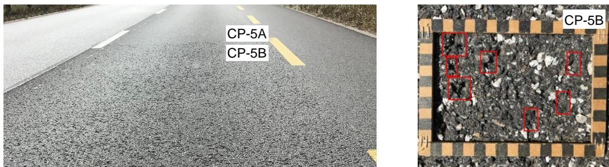
Abbildung 13: Links: Aufnahme der SMA 8 Beläge CP-5A (2-5 mm Abstreu) und CP-5B (5-8 mm Abstreu). Rechts: Nahaufnahme des CP-5B. Auf der linken Aufnahme sind die Kornausbrüche (Löcher) des gröbereren Abstreus deutlich sichtbar im Vergleich zu den feiner abgestreuten Körnern des CP-5A. Die einzelnen Kornausbrüche sind in der Nahaufnahme rot umrandet.
