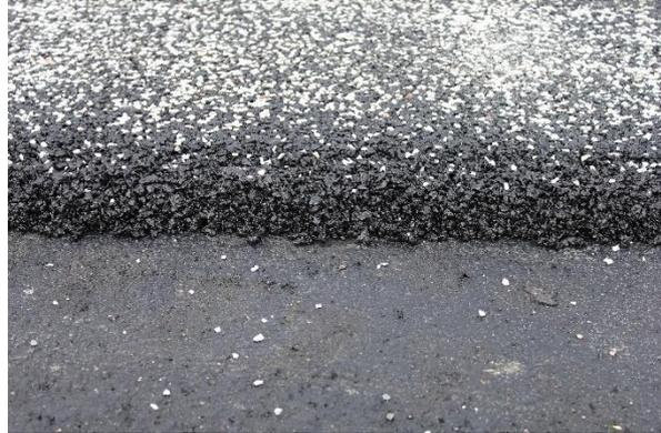
Abbildung 4: Nahaufnahme des eingewalzten hellen Splitts.
