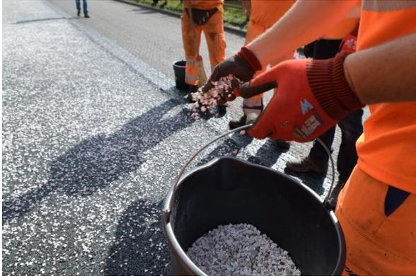
Abbildung 3: Belagseinbau mit Abstreuen von hellem Splitt.
