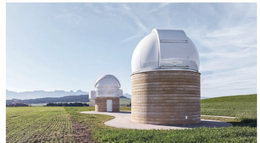
Observatoire de Zimmerwald: mise en œuvre clairvoyante des exigences d'exploitation
