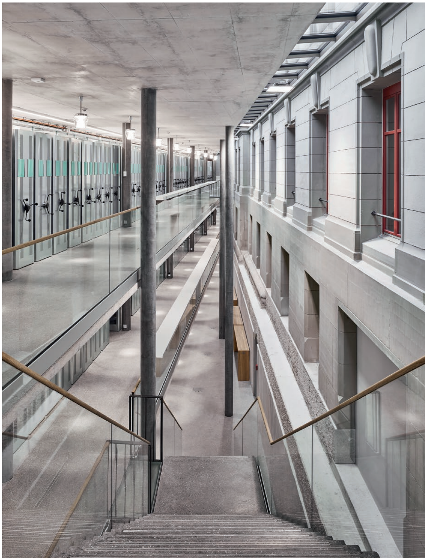
Bibliothèque de la Mittelstrasse à Berne: association de l'ancien et du nouveau
