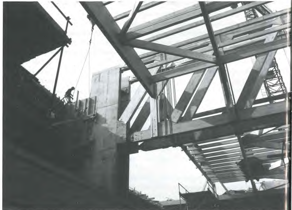
Aufriager für die Fachwerkträger
