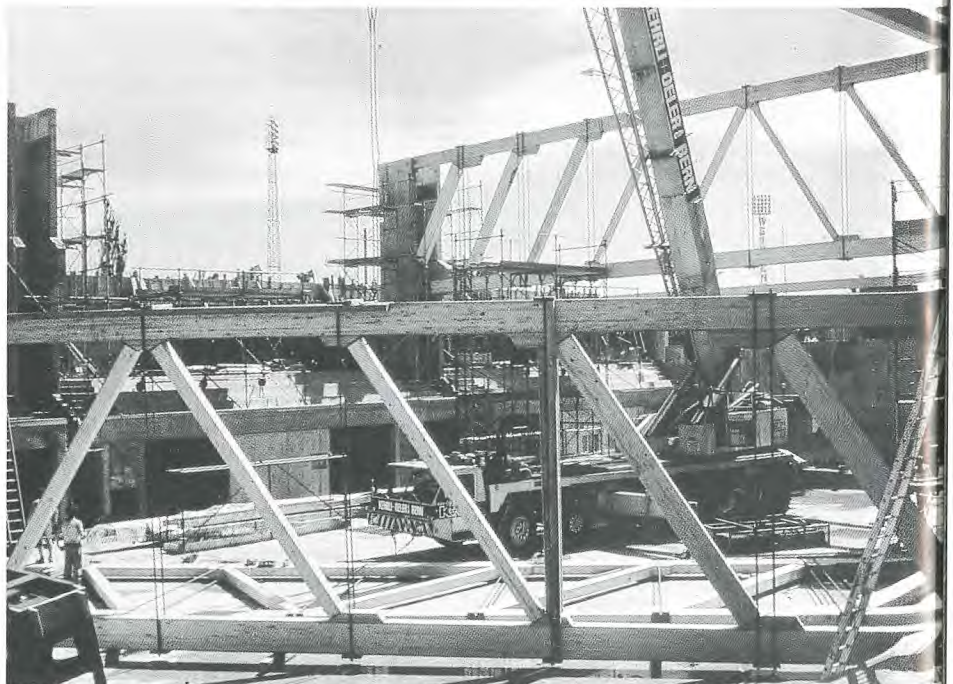
Montage der Howe'schen Träger
