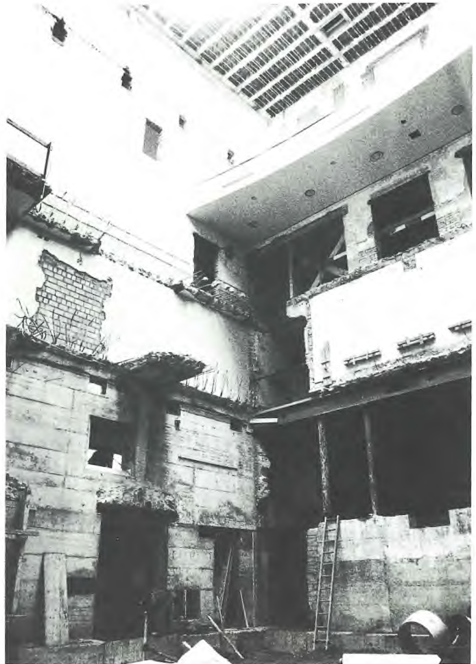
der Mitteltrakt in der Umbauphase
