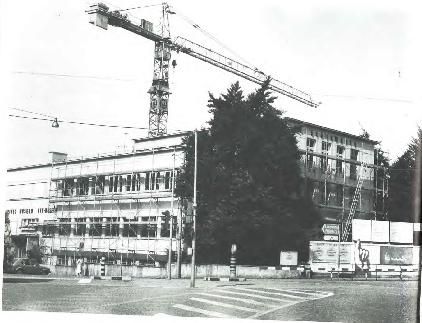
Gebäudeumbau am Helvetia
