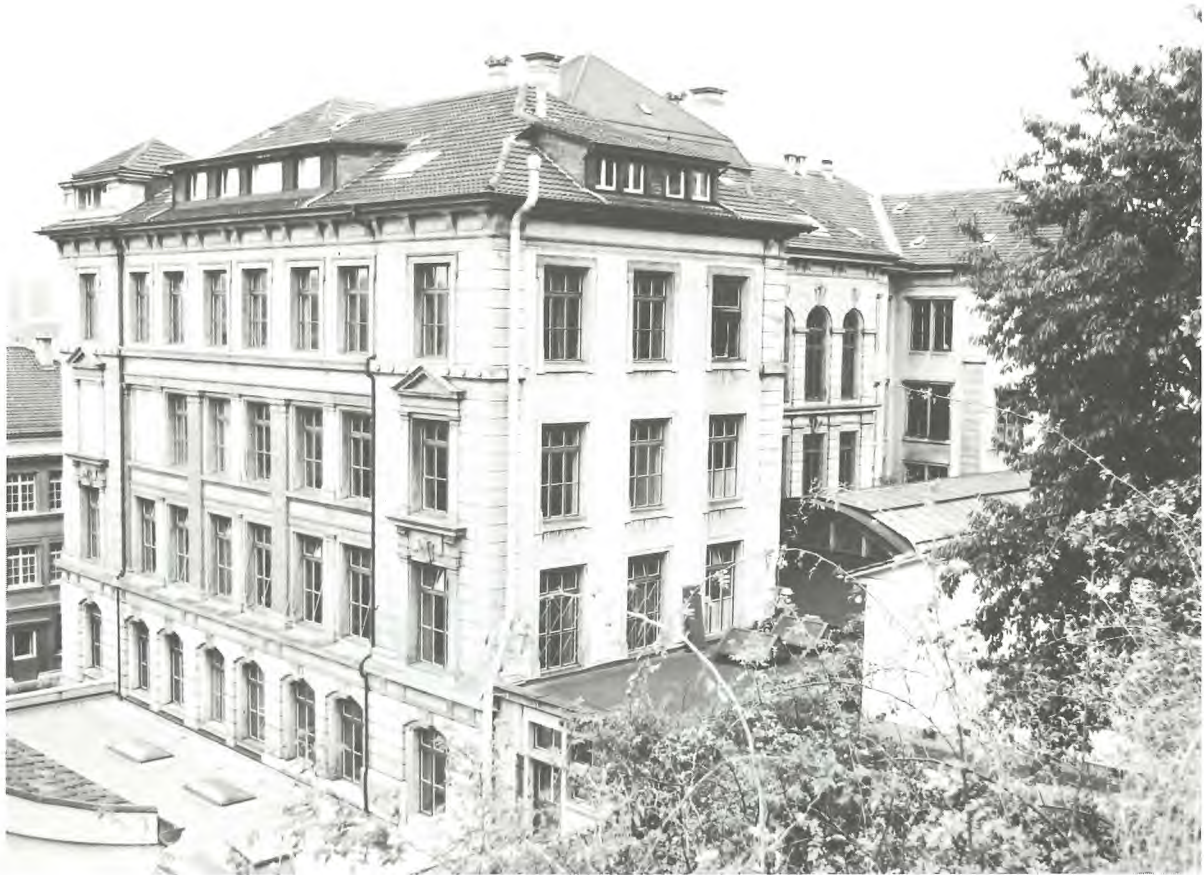
Südostfassade vor Umbauarbeiten / Façade sud-est avant les transformations
