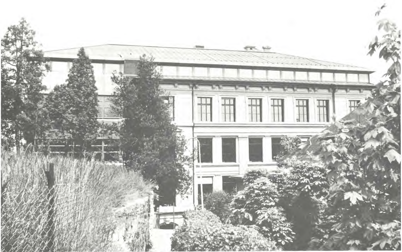
Westfassade / Façade ouest
