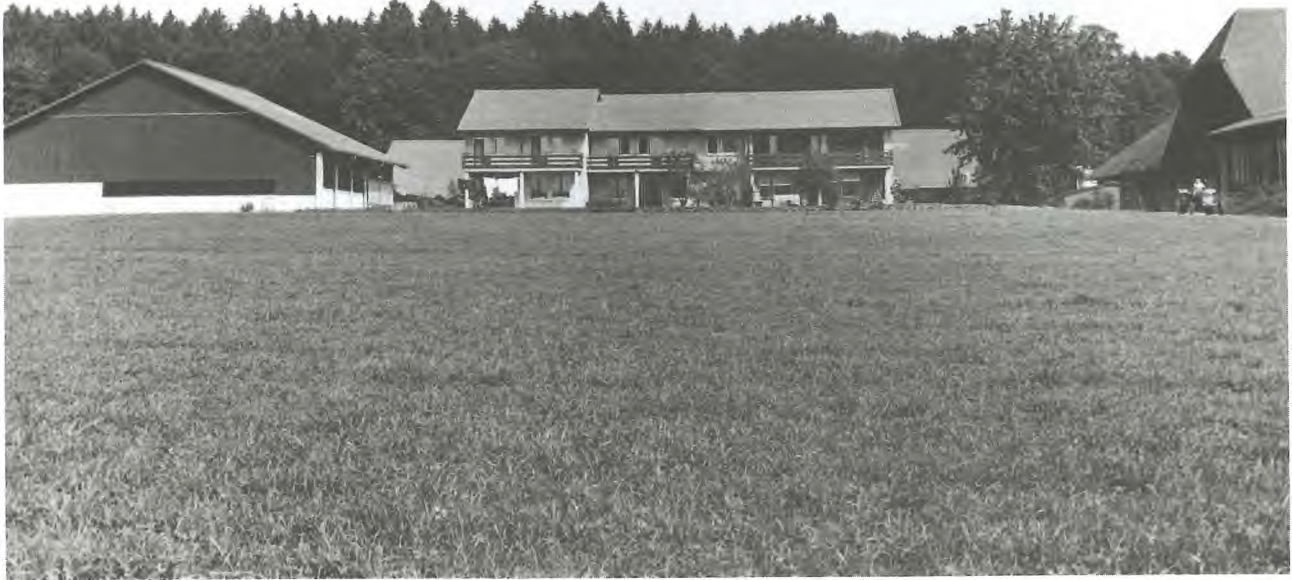
Bergeräume / Wohnungen / Mehrzweckgebäude von Westen
