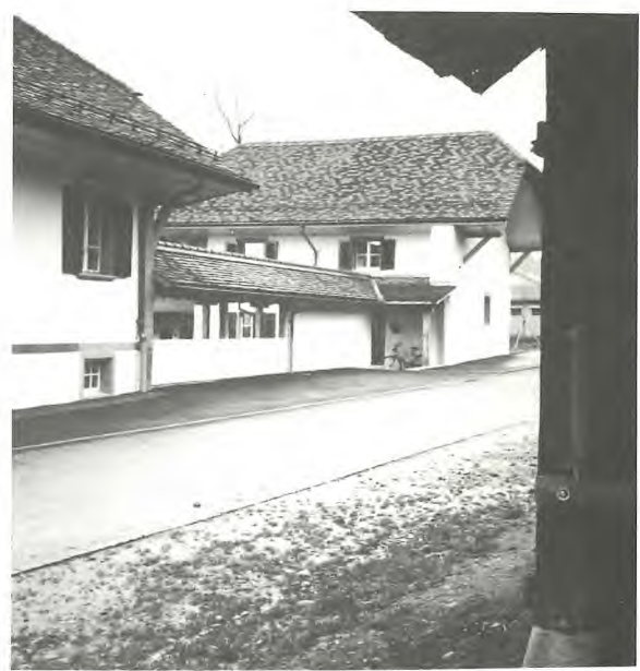
Betriebsberatung mit neuem Verbindungsbau
