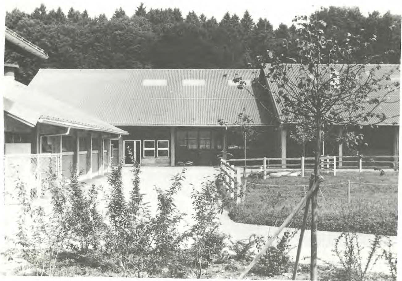
Milchviehscheune / Demonstrationsgebäude mit Maschinenhalle
