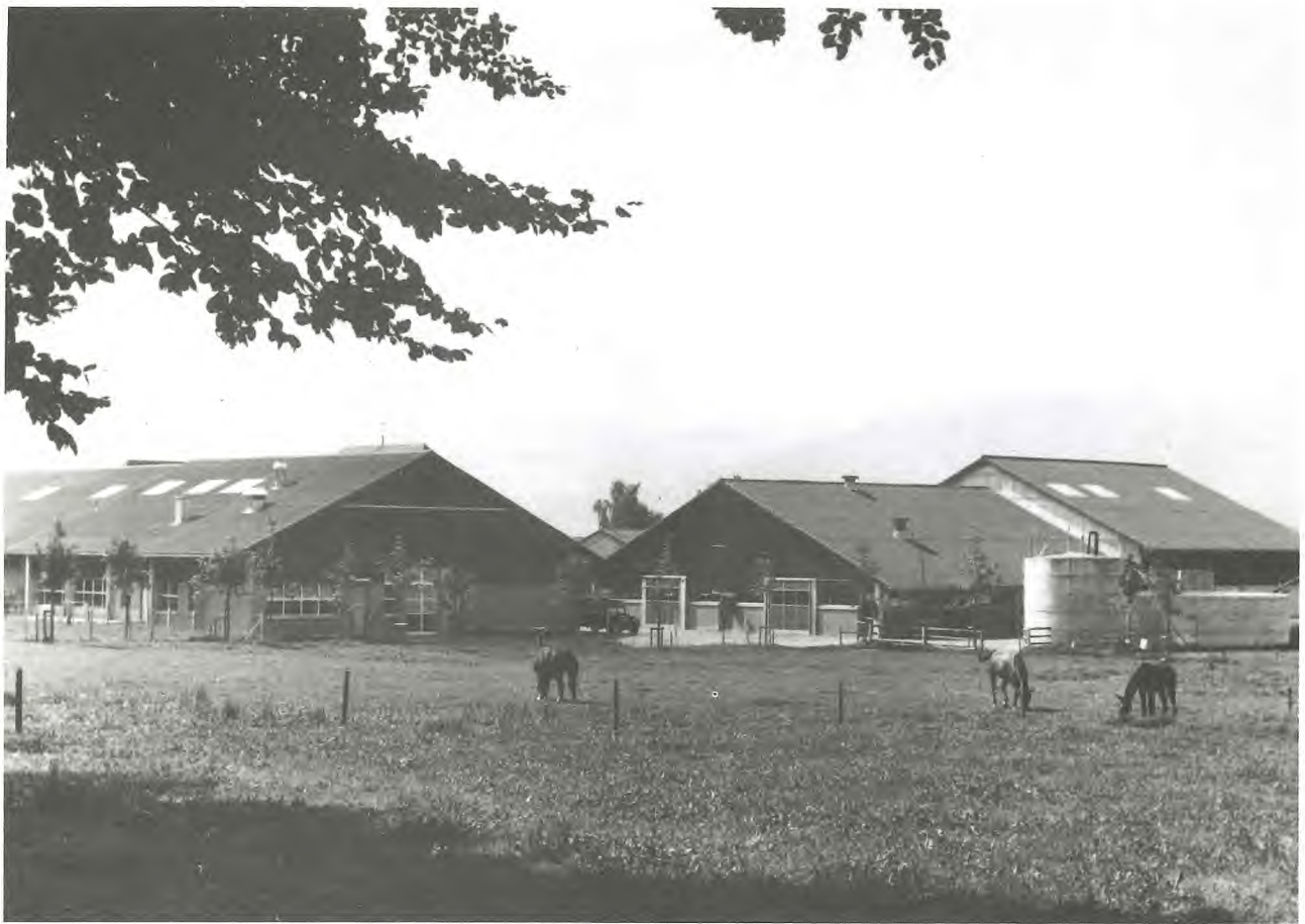
Demonstrationsgebäude / Milchvihscheune mit Bergeräume
