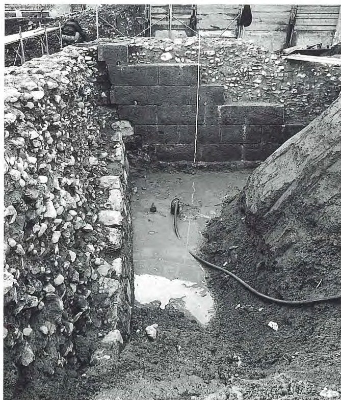
Einblick von Norden in die Baugrube nach der Entdeckung der Stadtmauer.
