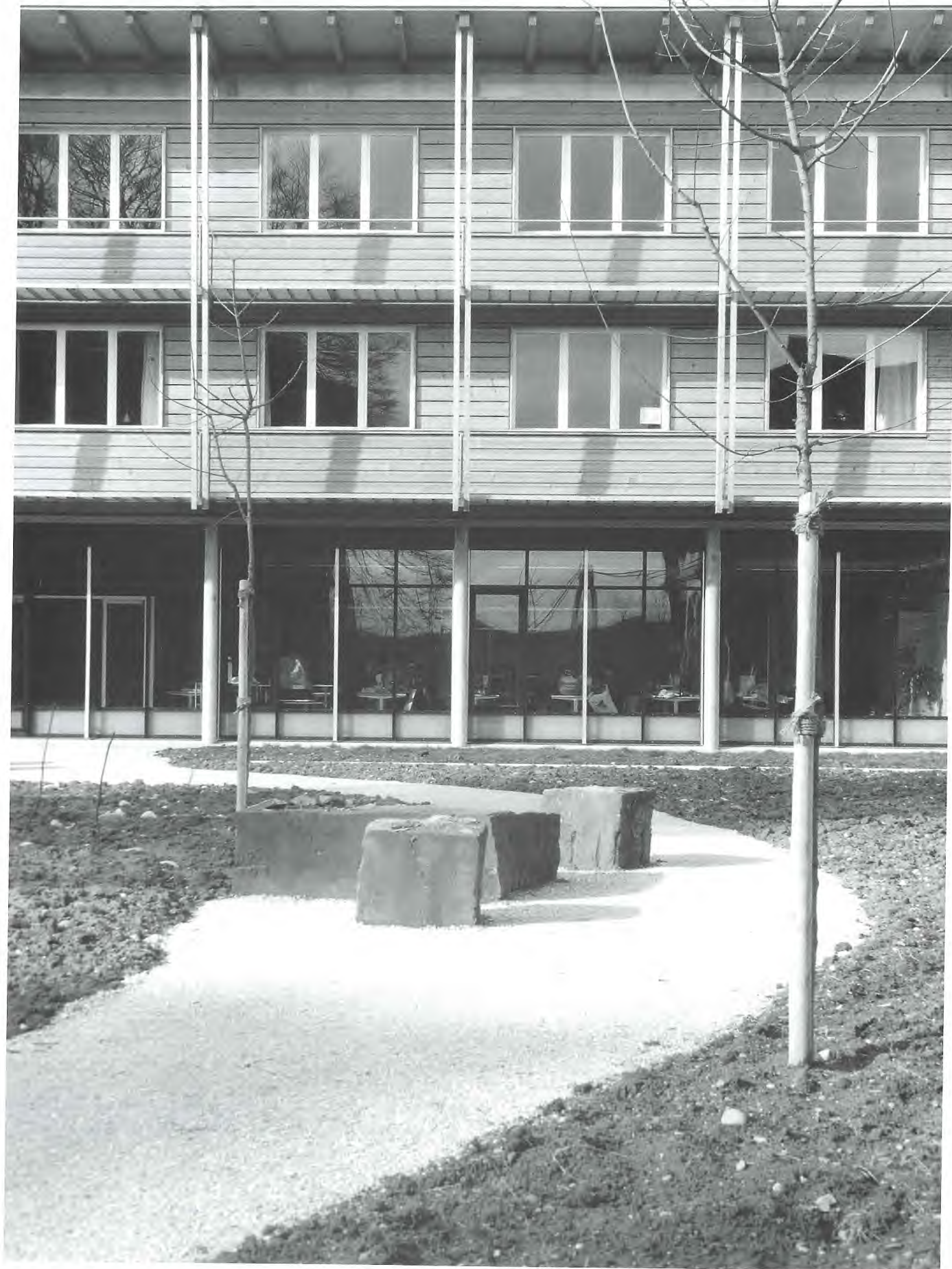
Kurs- und Internatsgebäude, Detail Südfassade
