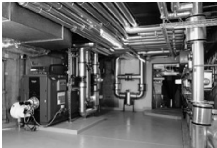
Spitzenlast-/Übergangskessel
