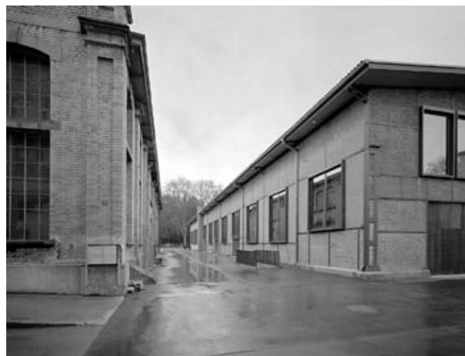
Fabrikstrasse 4b (links) und Hörsaalgebäude Fabrikstrasse 6 (rechts)
