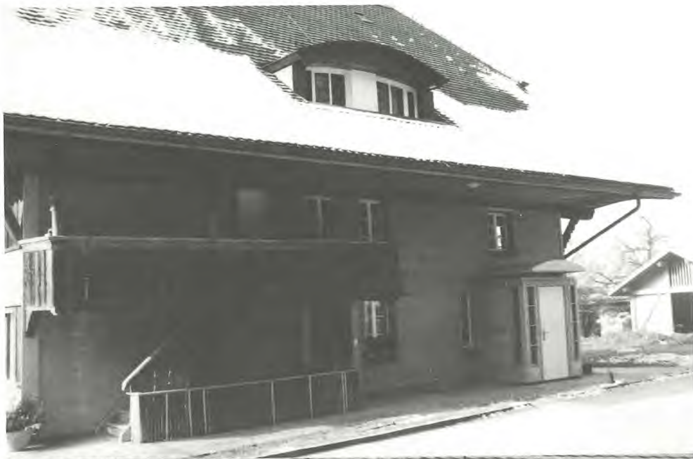
Eingangsfassade (Nordosten) renoviert
