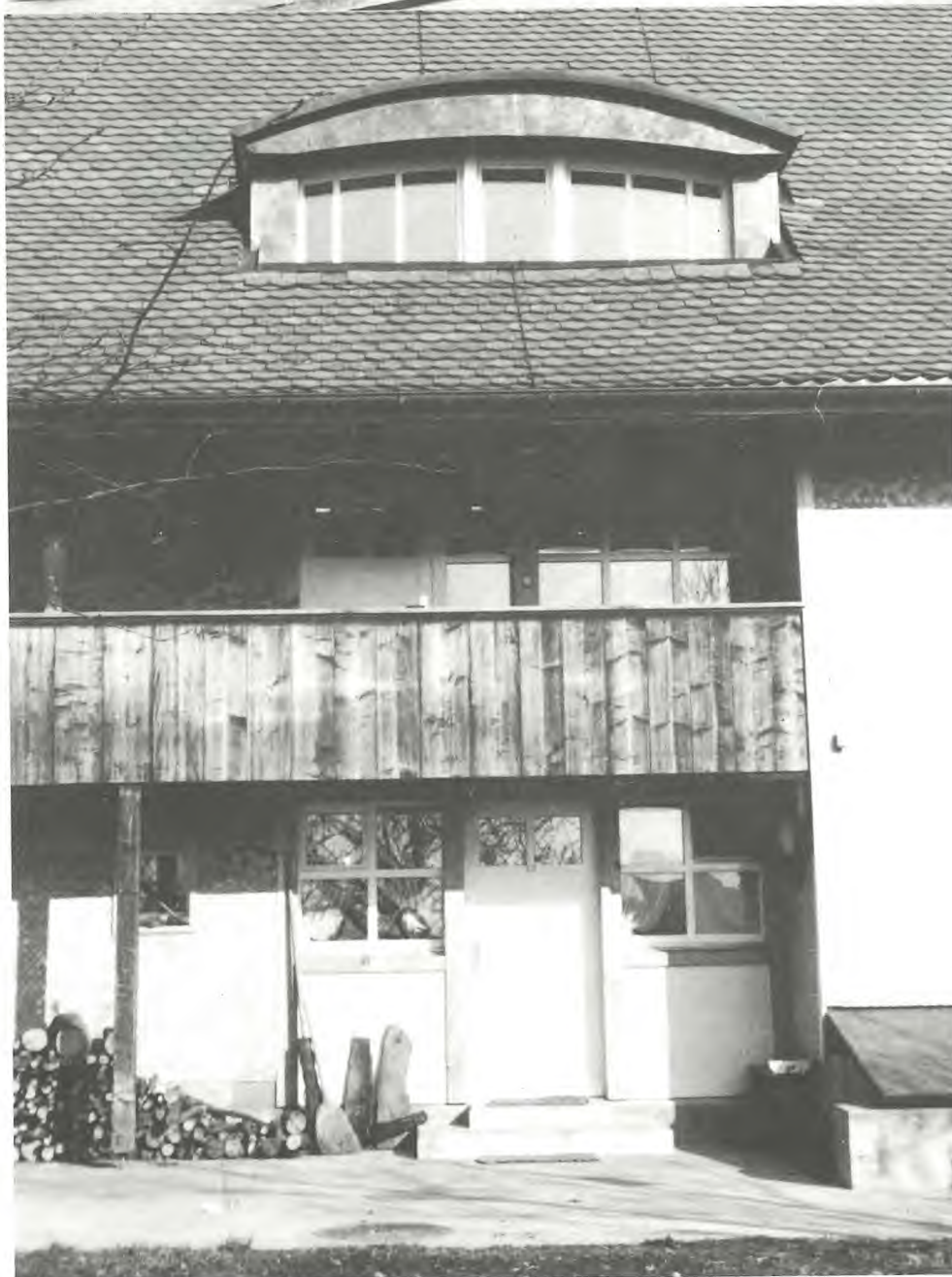
Hoffassade (Südwesten) renoviert
