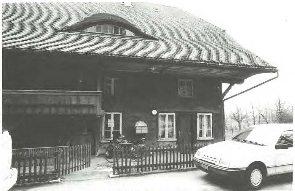
Eingangsfassade (Nordosten) vor Renovation
