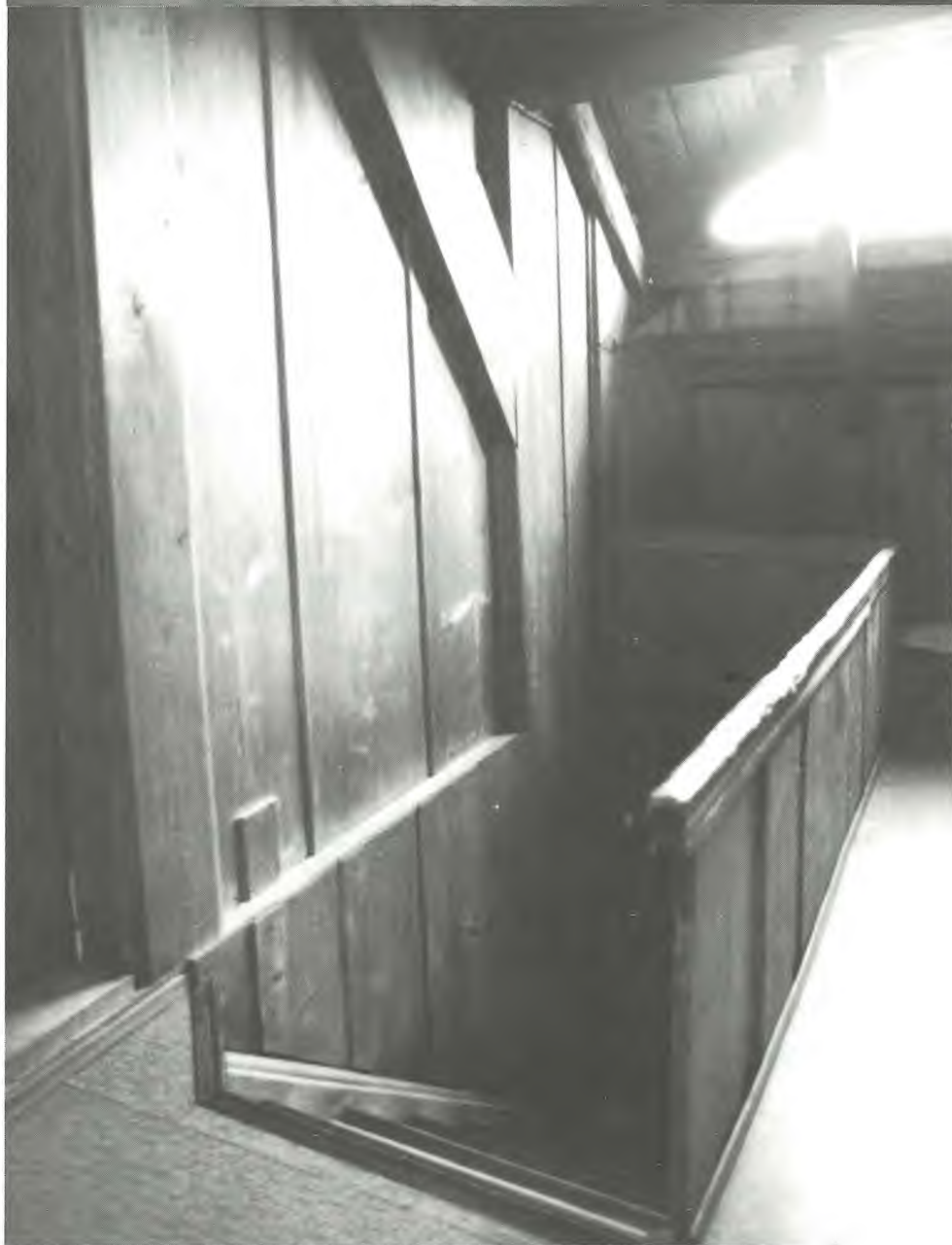
Aufgang ins Dachgeschoss vor Renovation
