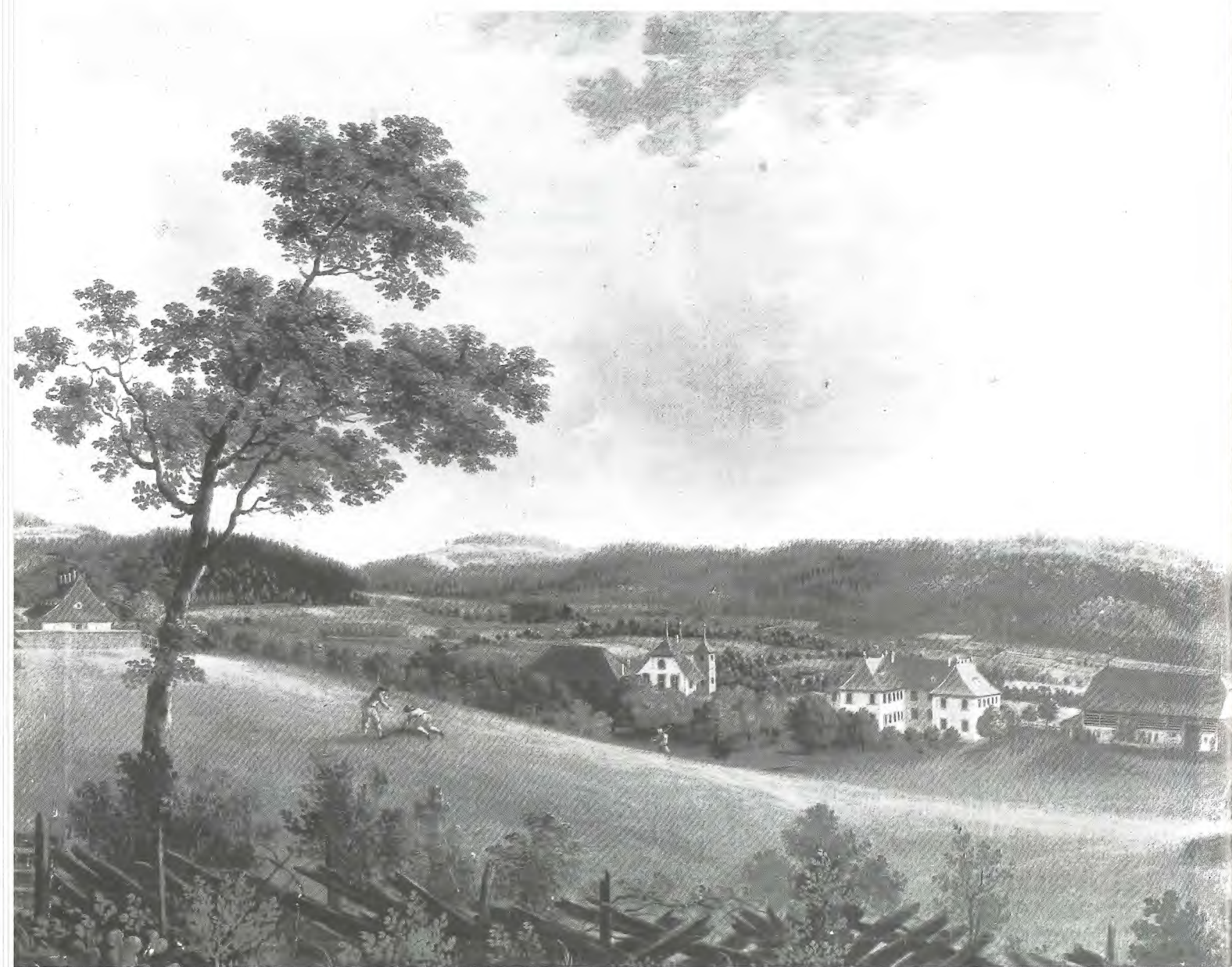
«Ausser Krankenhaus» des 18. Jahrhunderts Von links nach rechts: Tollhaus, altes Blatternhaus, Siechenschlössli, neues Blattern- spital, Siechenscheuer.
