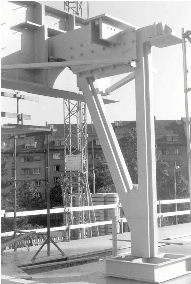
Dreieckförmiges Stahlteil in der abgestuften Stadtfassade
