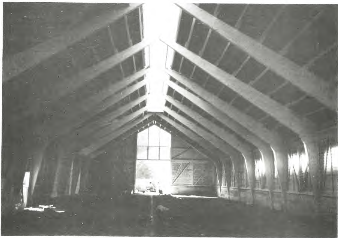
Innenansicht der Halle (im Bau)
