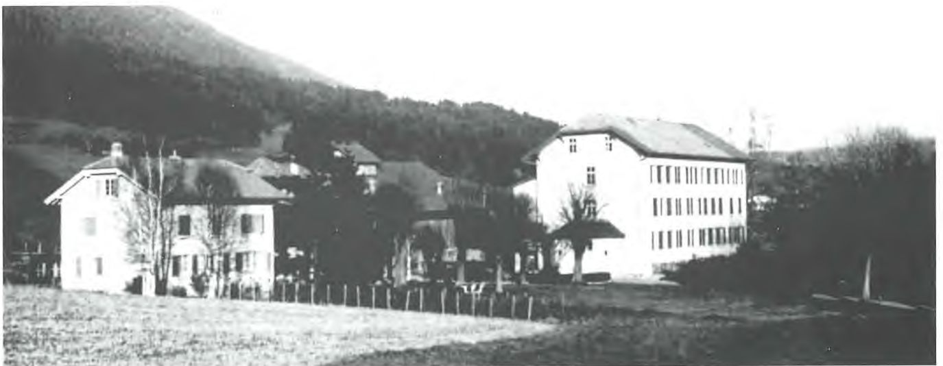
Vue du Foyer Beau-Site avant les travaux pour le Centre agricole
