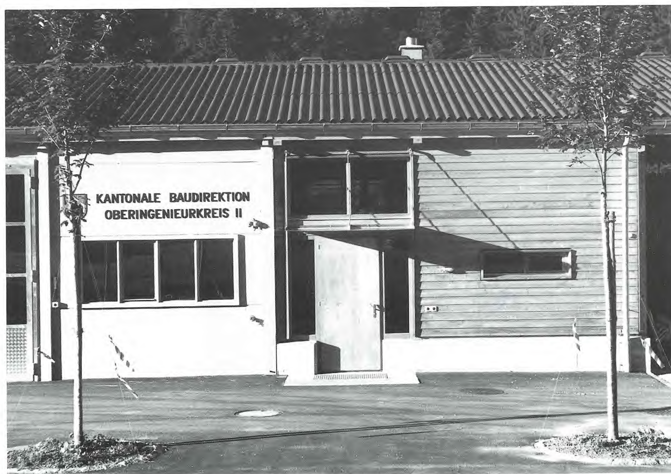
Oben: Gesamtansicht von Norden Unten: Eingang zum neuen Personaltrakt
