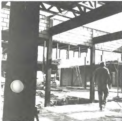
Februar 1980, Verbindungsbau / aile de raccord
