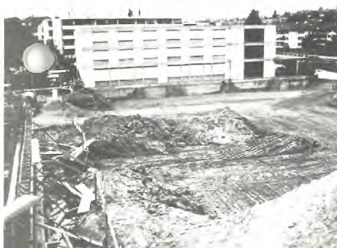
Juli 1979, Aushub Sporttrakt / Fouille sous-sol aile "Sport"
