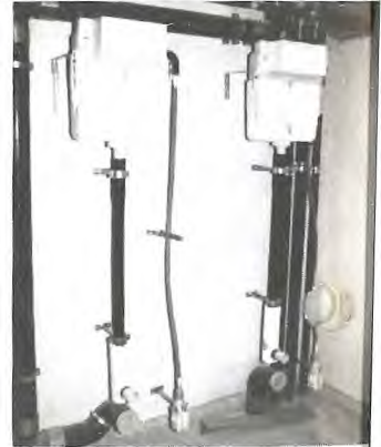
Januar 1980, Montagebeginn Installationen / Début installations
