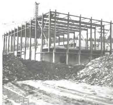
November 1979, Stahlbau Sporttrakt / charpente métallique aile "Sport"
