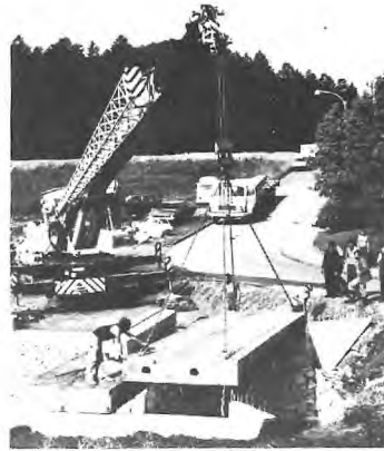
September 1978, neue Brücke Lutschenbach / nouveau pont sur Lutschenbach
