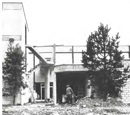
September 1980, Gartenanlage / travaux de jardinage
