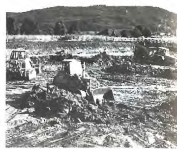
Oktober 1978, Beginn Aushub / Début fouilles
