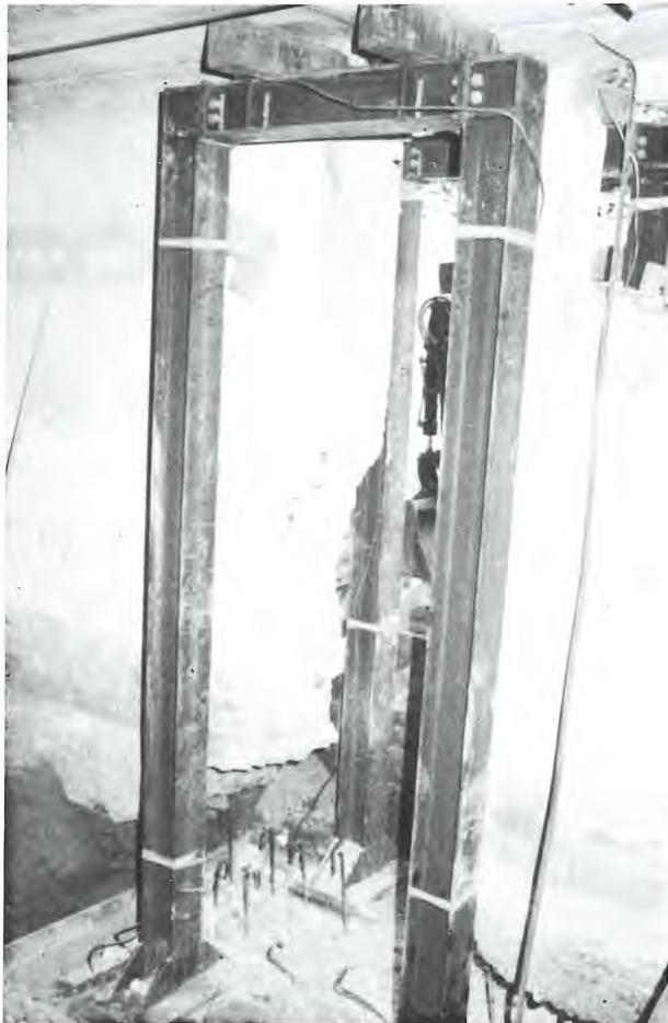
Abfangjoch Ostfassade Untergeschoss zum Einbau der neuen Stahlstützen für die neuen Fenster Schulungs- und Ausstellungsraum
