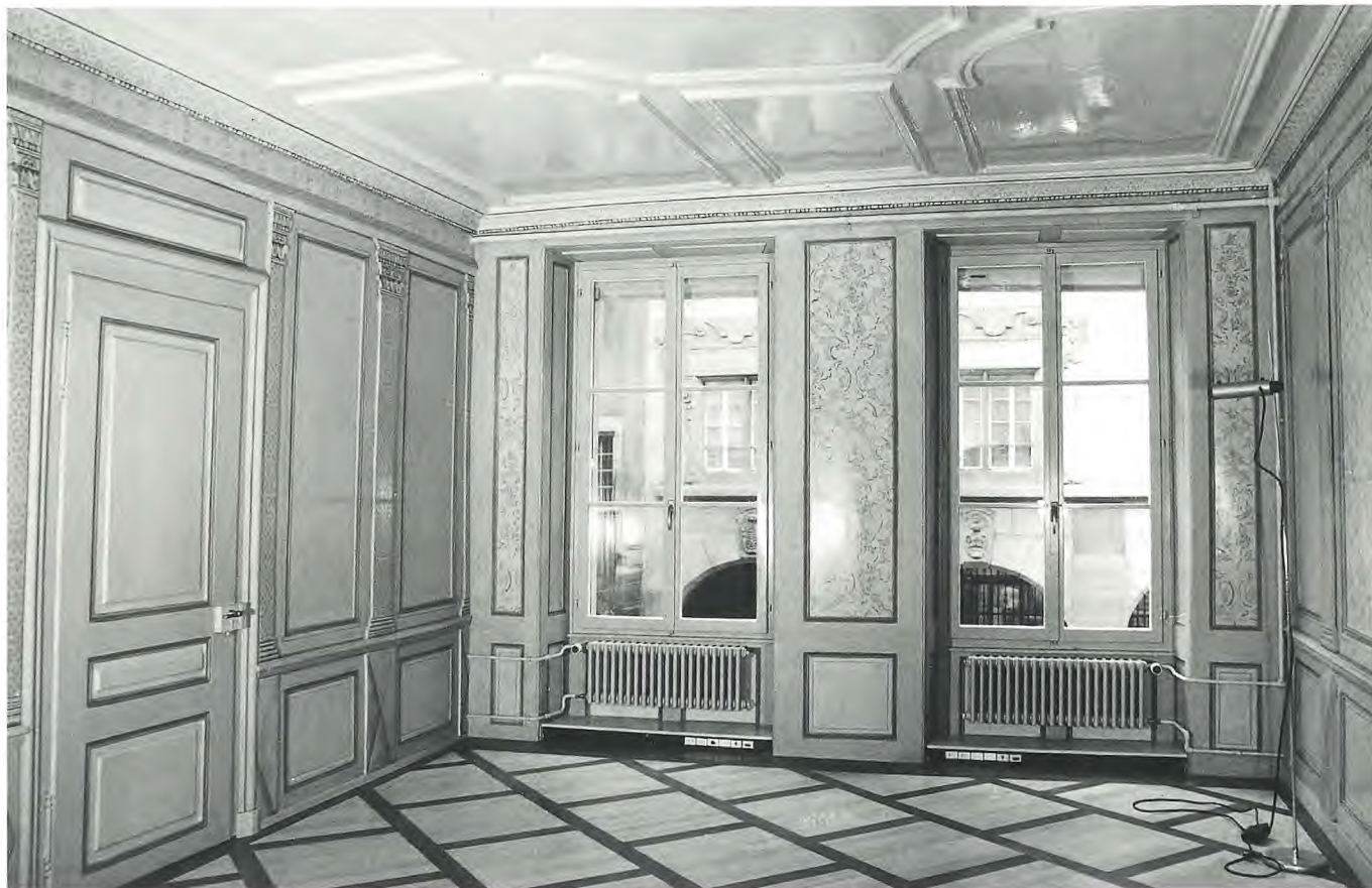
Vollenweiderhaus, Zimmer im 1. Obergeschoss Süd. Täfer nach Freilegung und Restaurierung der dekorativen dritten und damit jüngsten Fassung aus der Zeit um 1870.
