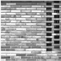
Fassade im Hauptgebäude
