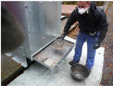
L'entretien correct des pare-balles artificiels (PBA) est essentiel au bon fonctionnement des systèmes et à la protection de la santé humaine. Les exploitants d'installations de tir sont responsables de la maintenance régulière et correcte du système pare-balles. Si les travaux d'entretien ne sont pas effectués correctement, les poussières de plomb et d'antimoine, qui sont dangereuses pour la santé, se dispersent dans l'environnement.
