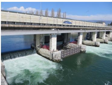
L'installation de régulation de Port, construite entre 1936 et 1939, est un élément central de la correction des eaux du Jura. Outre le barrage, l'installation comprend une écluse, un pont routier et, depuis 1995, une centrale hydroélectrique. Le barrage de Port permet de réguler le niveau d'eau des trois lacs du pied du Jura (lacs de Bienne, de Neuchâtel et de Morat) ainsi que le débit de l'Aar en aval.
