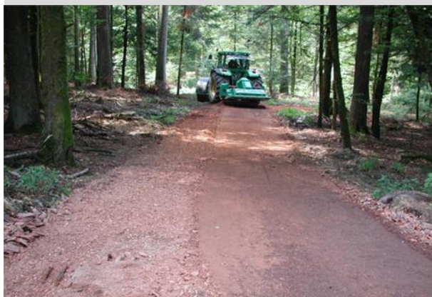
Pose conforme de granulat de tuiles
