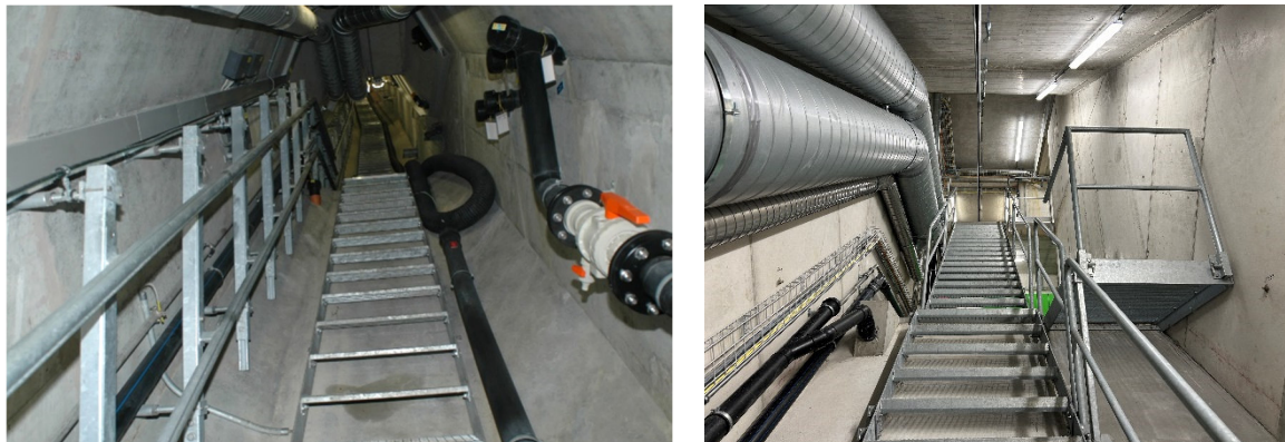
Image 4: Vues intérieures du puits incliné (à gauche dans la partie inférieure, à droite dans la partie supérieure)
