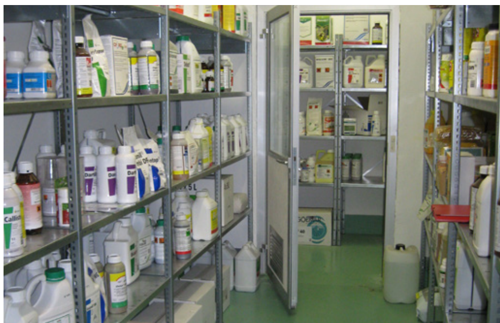
Dépôt de matières dangereuses pour l'environnement et toxiques: compartiment coupe-feu séparé aéré ou ventilé dont le sol résiste aux produits stockés.
