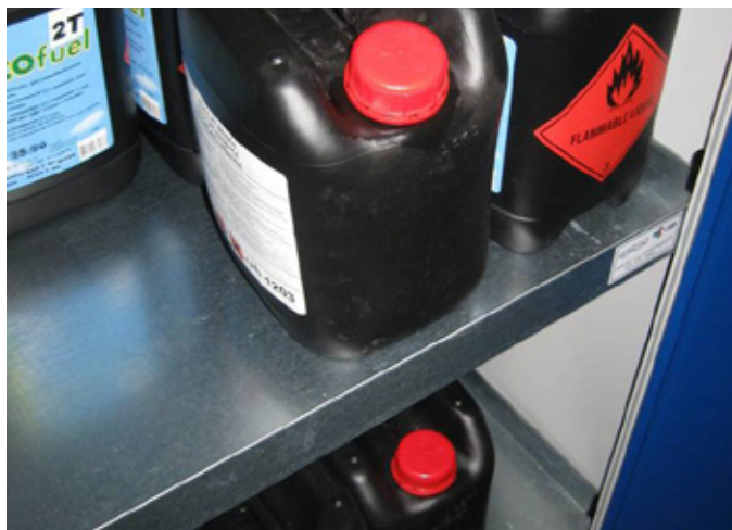
Les liquides inflammables doivent être entreposés dans une armoire incombustible munie d'un bac de rétention...
