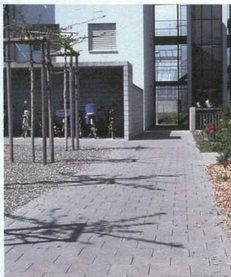
En cas de fortes pluies, l'eau peut s'écouler sur les terrains avoisinants. Il n'est dès lors pas nécessaire d'installer des dépotoirs et des conduites d'évacuation des eaux.
