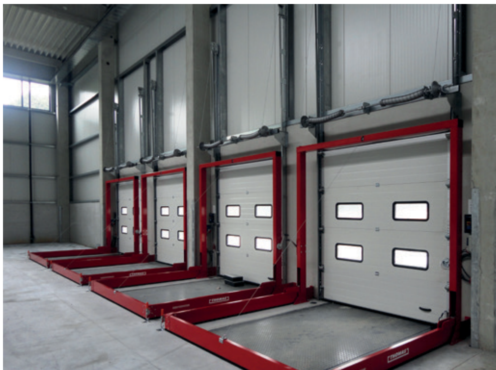
Barrières à eaux d'extinction automatiques pour quais de chargement
