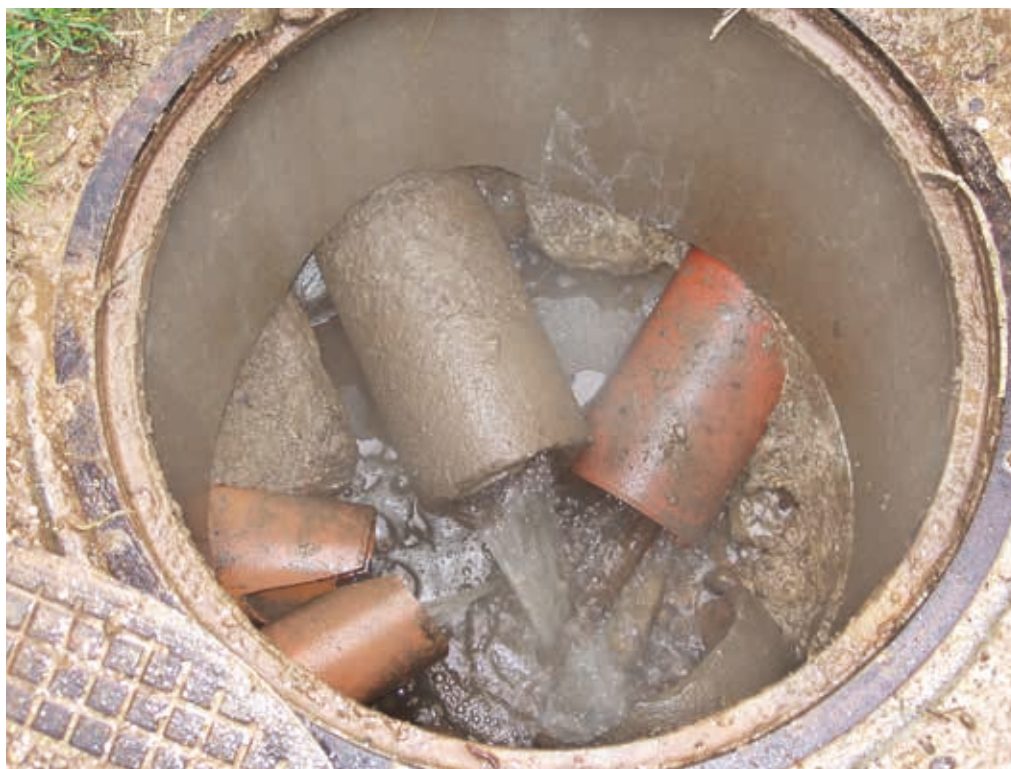
Fig. 19: Les contrôles de réception visent à ce que de tels «bricolages» ne se produisent plus.
