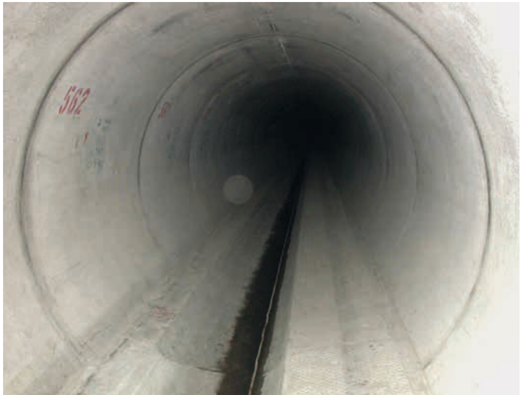
Fig. 16: En matière de canalisations, les canaux de retenue constituent des ouvrages spéciaux importants – leur construction relève de la catégorie « mesures relevant de la conception des systèmes d'évacuation des eaux ».
