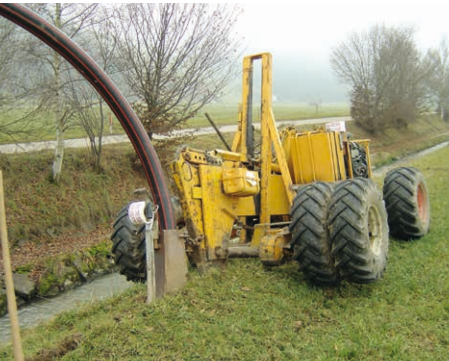
Abb. 1: L'une des mesures fréquentes en lien avec le PGEE en zone rurale consiste à raccorder des biens-fonds aux canalisations, par exemple ici par l'enfouissement d'une conduite
