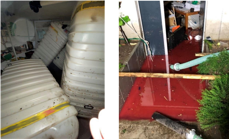
III. 1 : Citerne en matière synthétique renversée (à g.) suite à une inondation. À dr. : cave inondée et fuite de mazout (reconnaissable à la couleur rouge).
