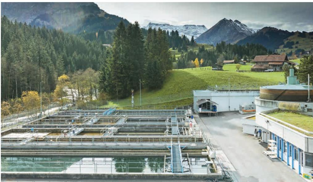
Grâce à l'agrandissement de la STEP d'Adelboden, les concentrations d'ammonium provenant des eaux usées traitées sont nettement moins élevées en aval de la station d'épuration.
