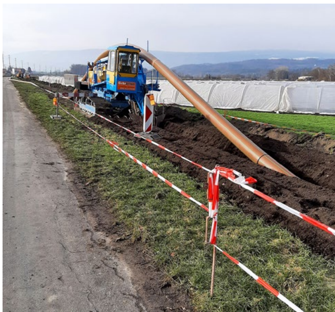
Construction de la conduite de raccordement de la STEP d'Ins à la STEP de Marin. © STEP d'Ins
