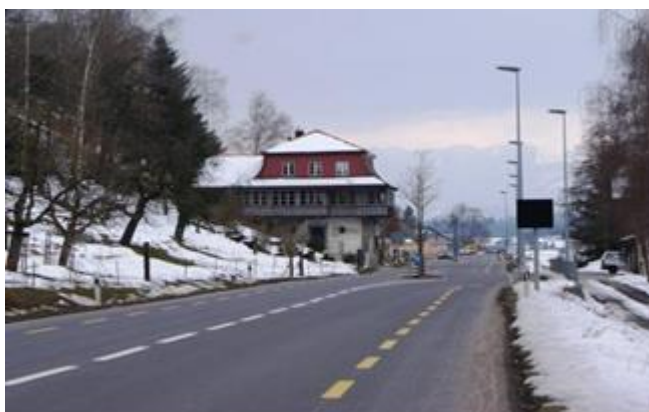
Route cantonale Wichtrach–Kiesen
