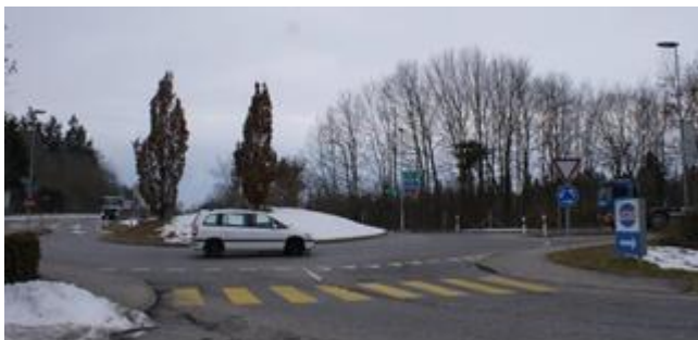
Exemple de la jonction autoroutière de Thounen nord
