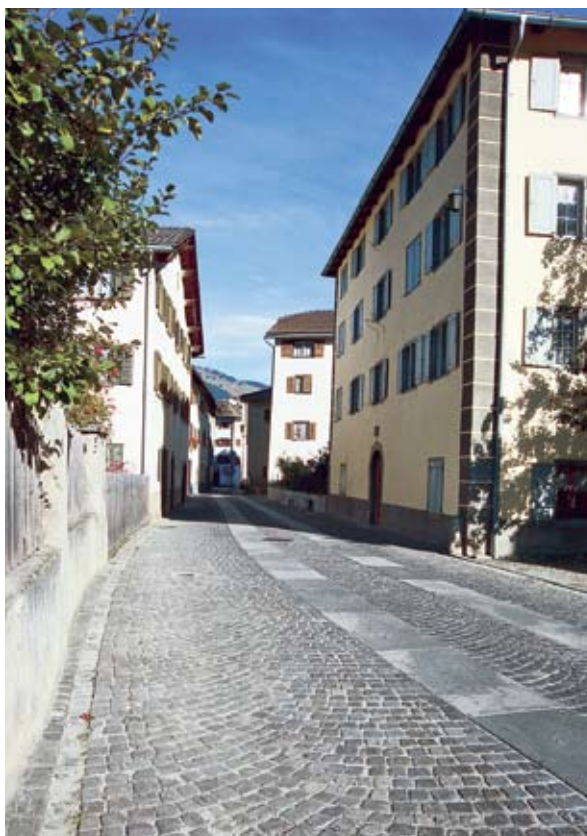
Rue pavée à l'intérieur d'une localité, avec des pavés disposés en arcs de cercle. Les deux bandes de roulement dallées, inspirées du modèle historique des routes pour diligences, améliorent le confort de la circulation et réduisent le bruit. Andeer GR (ViaStoria/Heinz Dieter Finck).
