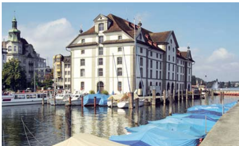
Sur les voies de communication historiques, de nombreux édifices de prestige étaient directement liés au trafic commercial. Le grenier de la principauté abbatale de Saint-Gall au port de Rorschach SG (ViaStoria/Heinz Dieter Finck).
