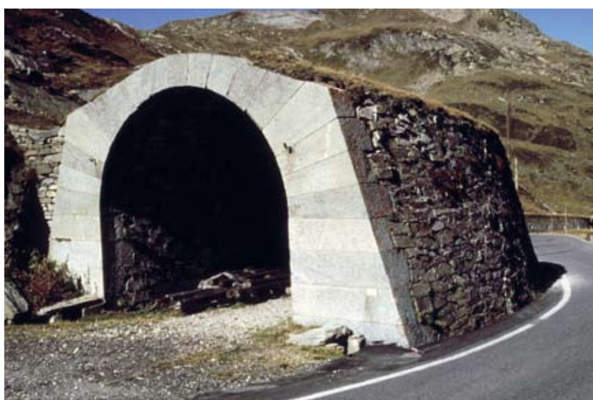
Galerie pare-avalanches sur le versant nord du col du Splügen GR. Grâce à ces galeries, le col fut rendu praticable en hiver dès les années 1840 (ViaStoria/Arne Hegland).
