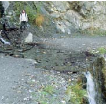
Gué maçonné dans les Alpes, avec un haut mur de soutènement du côté aval, sur l'ancienne route de la vallée de Binn VS (ViaStoria/Guy Schneider).
