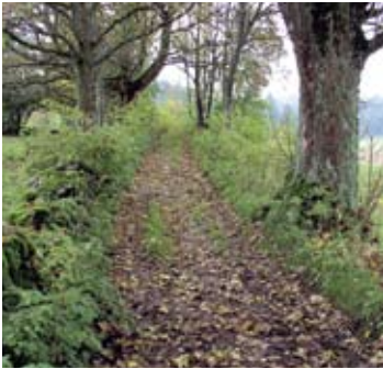
Cette voie charretière typique, bordée de murs, d'arbres et de buissons, montre une surface non consolidée en matériau meuble. La Ferrière BE (ViaStoria/Guy Schneider).
