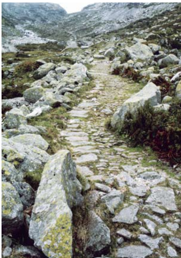
Le sentier muletier du Gothard, au Mätteli, entre Hospental UR et le col. Après dégagement, la structure du dallage est redevenue parfaitement visible (ViaStoria/Heinz Dieter Finck).
