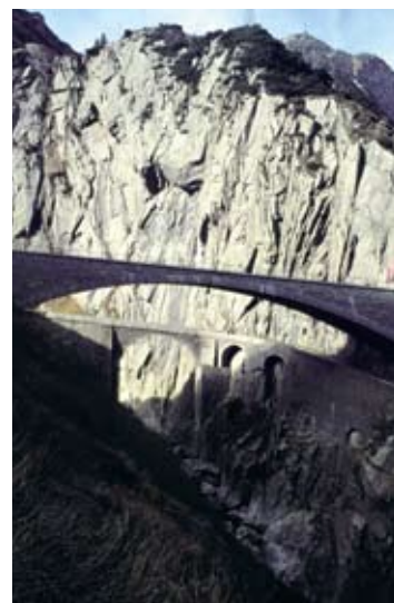
Délestage d'un pont grâce à une nouvelle construction: le «pont du Diable», bâti en 1830 sur la route du Gothard n'était pas adapté au trafic automobile. Il a été délesté grâce à la construction, en 1955/1956, d'un nouveau pont. Gorge des Schöllenen UR (ViaStoria/Cornel Doswald).
