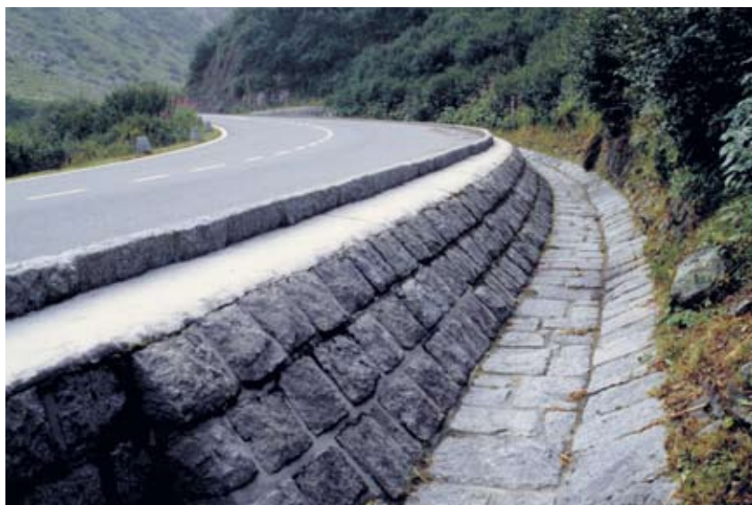
Fossé en pierres de taille liées au ciment. Sa forme strictement géométrique n'est pas dans l'esprit de la route historique. Route du Gothard UR (ViaStoria/Arne Hegland).
