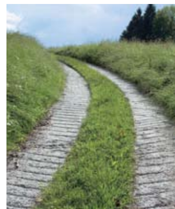
Chemin d'exploitation agricole, habilement aménagé à l'aide de bandes de roulement en béton, pourvues de stries pour une meilleure adhérence. Fahrmi BE (ViaStoria/Guy Schneider).
