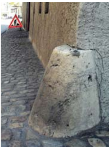
Bouteroue taillée, en calcaire du Jura, à l'angle d'une maison de Thoune BE (ViaStoria/Guy Schneider).
