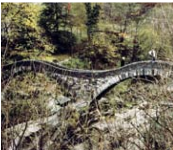
Reconstruction partielle: le pont de la Verzasca à Lavertezzo TI est un bon exemple de reconstruction d'une arche qui s'était effondrée. L'arche conservée a servi de modèle pour la reconstitution menée dans les années 1950, de main de maître, selon des méthodes artisanales (ViaStoria/Arne Hegland).
