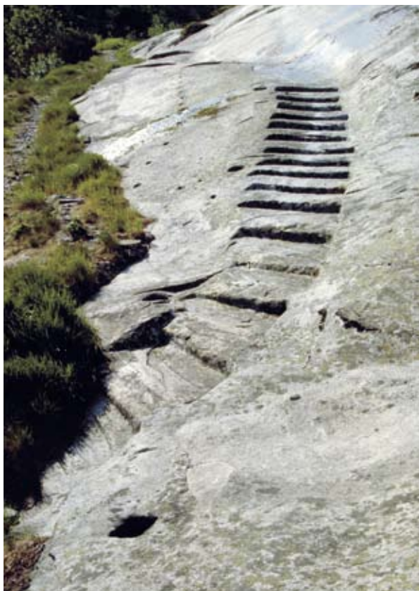
Roche: marches taillées dans le granit facilitant le passage sur la roche polie par les glaciers. «Hälenplatte», sur le chemin muletier du Grimsel, Guttannen BE (ViaStoria/Guy Schneider).
