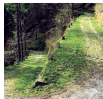
La substance historique des chaussées qui n'ont jamais été réaménagées est souvent remarquable. La «route des diligences» entre Vernayaz et Finhaut VS, riche d'une quarantaine de virages en épingles à cheveux (ViaStoria/Sandro Benedetti).
