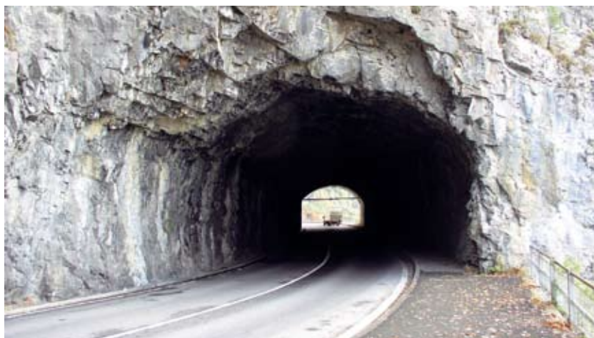
Tunnel de 1884, creusé dans le calcaire, non transformé, mais pourvu postérieurement d'un trottoir. Route de Beatenbucht au bord du lac de Thoue BE (ViaStoria/ Guy Schneider).
