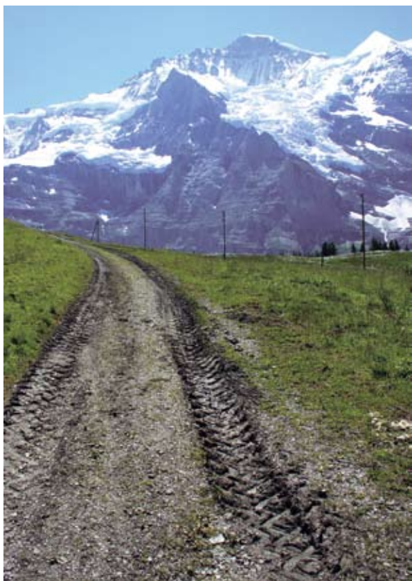
Matériau meuble: chemin d'exploitation agricole avec surface de terre et sable mêlés. Wengernalp BE (ViaStoria/Guy Schneider). Voir p. 51.
