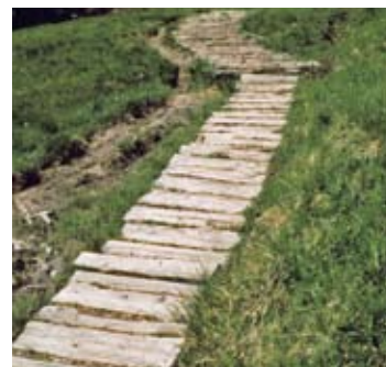
L'«Alter Schwyzerweg», au-dessus d'Ibergeregg SZ, franchit une zone humide sous la forme d'un segment de chemin de madriers (ViaStoria/Arne Hegland). Voir aussi ill. p. 36.
