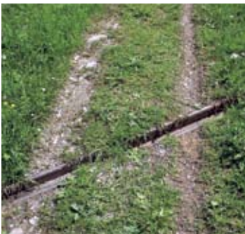
Traverse diagonale métallique. Bien que ce genre de traverses soit réalisé dans un matériau étranger à la construction traditionnelle, il est plutôt discret et on peut envisager de l'installer en quantité raisonnable même sur des chemins historiques (ViaStoria/Guy Schneider).
