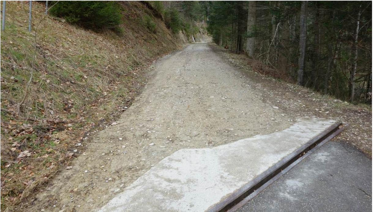
III. 54: Chemin stabilisé au moyen d'un mortier. Il a été renoncé ici à la pose d'une couche d'usure. (2016)
