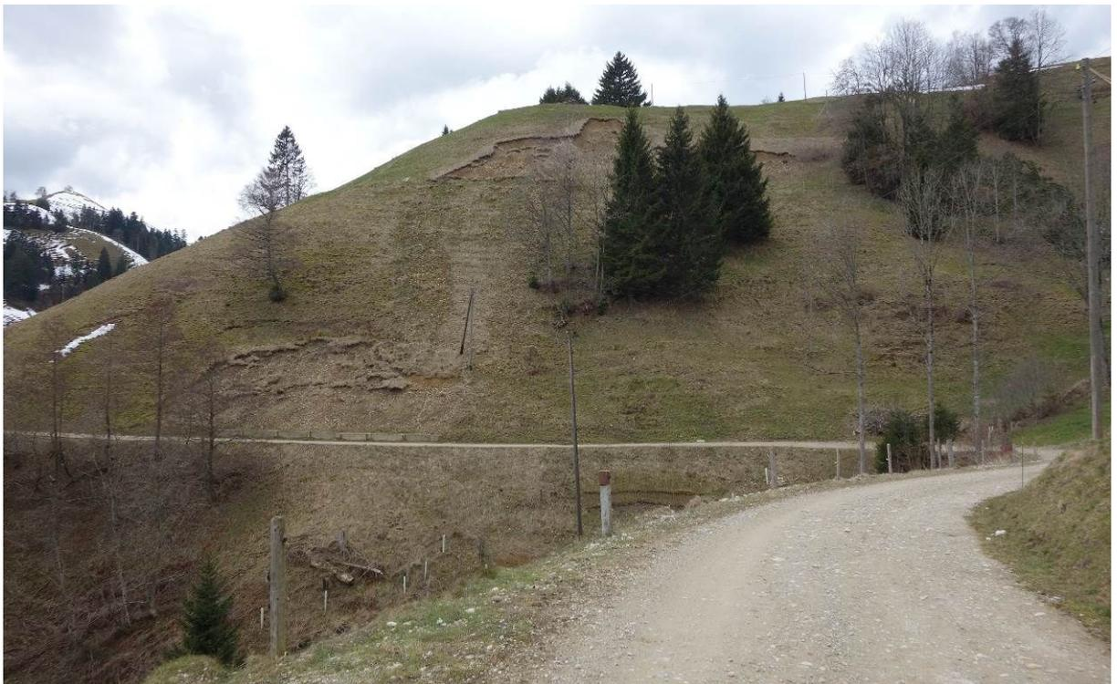
III. 55: Ce qui apparaît ici comme un chemin empierré parfaitement usuel est en fait un chemin d'accès stabilisé au moyen d'un mortier. On aperçoit encore sur la pente les traces du glissement de terrain qui a rendu l'assainissement nécessaire. (2016)
