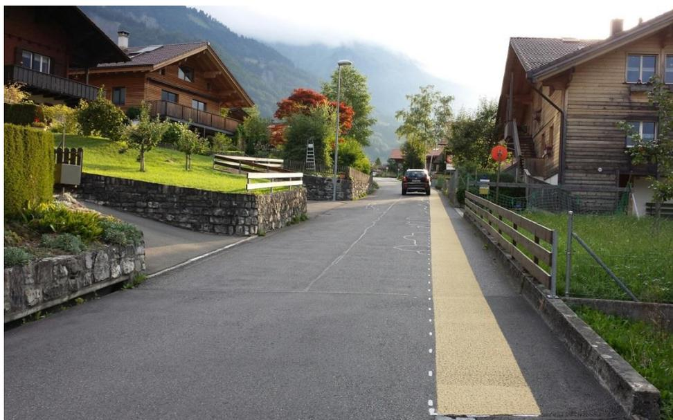
Bande large jaune sable (RAL 1002 « Jaune sable ») unilatérale. Réalisée au moyen de plastique à froid, elle rétrécit visuellement la chaussée. Elle permet d'améliorer le respect mutuel des usagers de la route.
