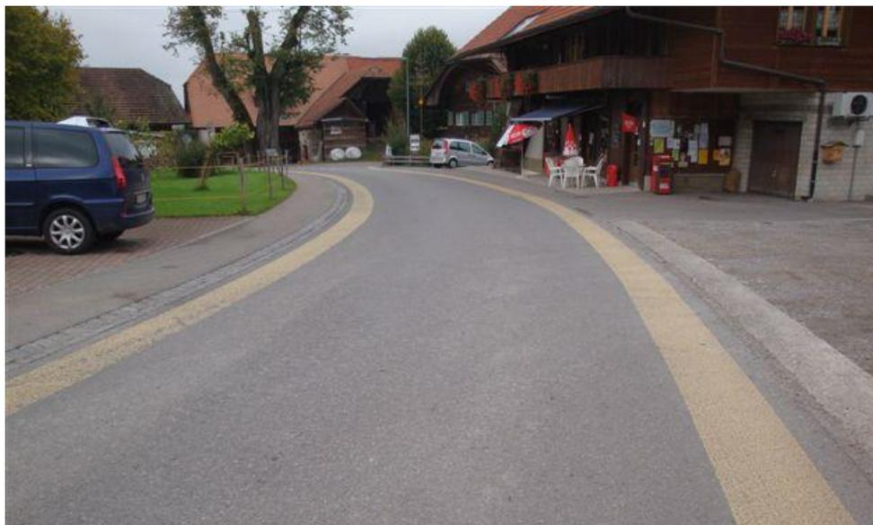
La couleur (RAL 1002 « Jaune sable ») offre un bon contraste et crée un effet d'optique adéquat. Les traces d'usures (à gauche) apparues peu de temps après l'application indiquent néanmoins que les bandes larges doivent être régulièrement renouvelées. Pour ce type d'usure, vérifier de manière générale s'il ne s'agit pas d'un dommage couvert par la garantie.
