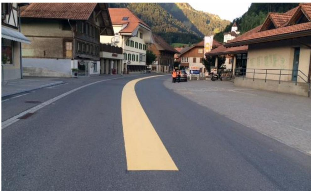
Jaune sable (RAL 1002), réalisation en Granoplast. Largeur insuffisante pour un marquage officiel des bandes polyvalentes. Indique une modification du régime de circulation. Les piétons peuvent traverser où bon leur semble dans la zone située entre la Coop et la banque. Rétrécissement visuel des voies de circulation après l'effacement des passages pour piétons.
