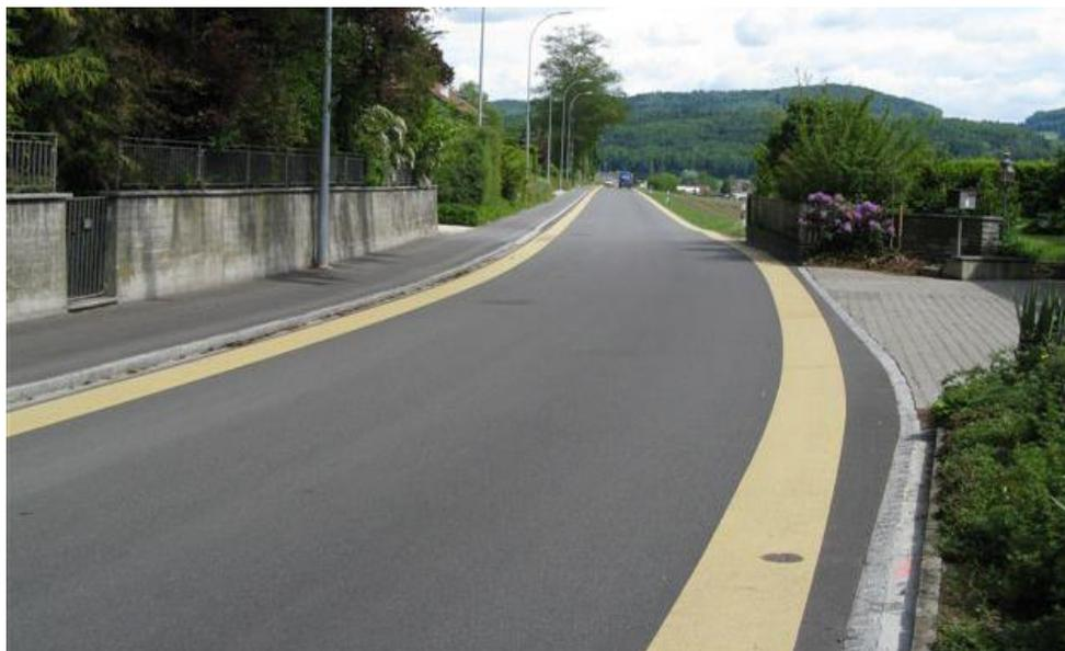
L'hétérogénéité du bord de la chaussée aurait pu être compensée par des bandes larges. Bon contraste : le choix de la couleur (RAL 1002 « Jaune sable ») est conforme à la norme SN 640 214 et aux standards de l'OPC pour les routes cantonales. Les bandes sont efficaces et rétrécissent visuellement la chaussée.
