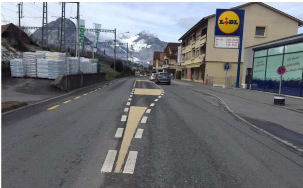
Jaune sable (RAL 1002), réalisation en Granoplast. Marquage des bandes polyvalentes et de la sinuosité de la chaussée. Efficace et s'harmonise bien avec l'environnement.
